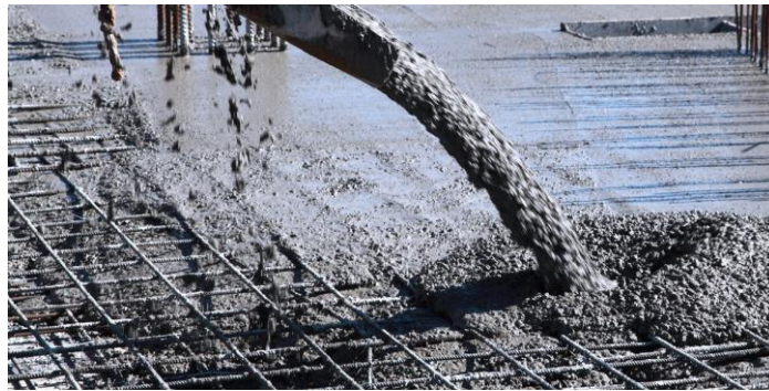
Imagen 1. Vaciado de concreto en obra. Fuente: Gestión Solidaria. https://www.gestionsolidaria.com/
