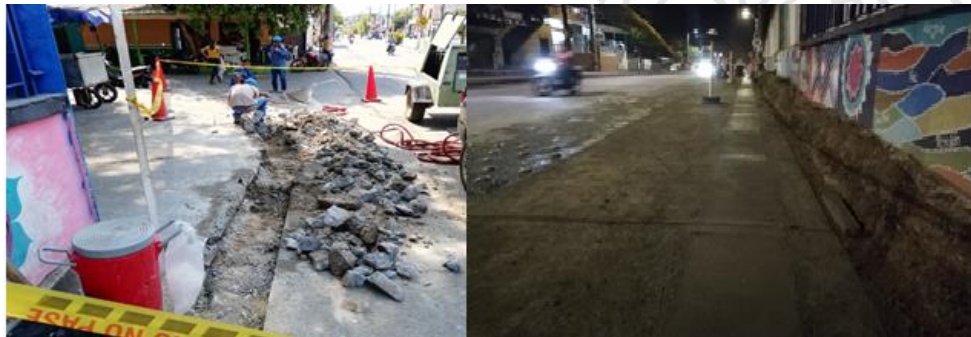
Ilustración 12. Instalación de alcantarillado.
