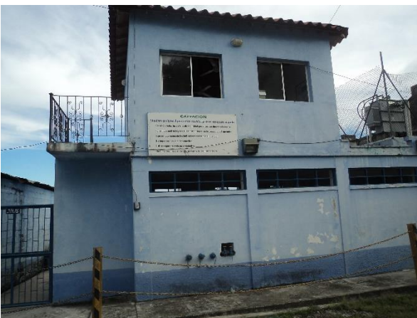
Ilustración 6. Fachada planta de captación.
