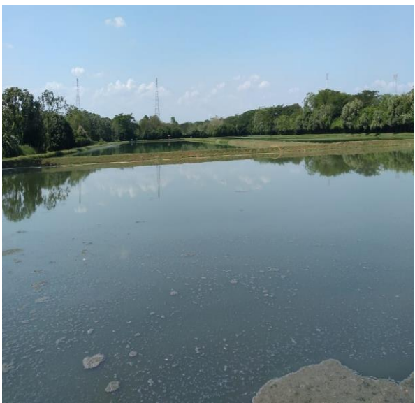
Ilustración 13. Laguna de oxidación.
