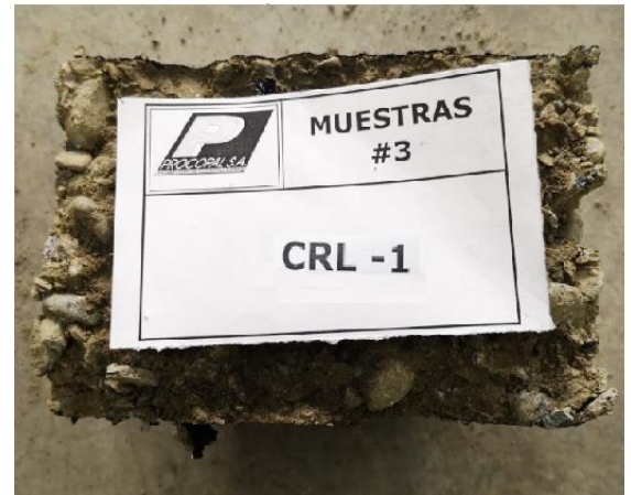
Ilustración 20. Toma de medida briqueta #3. CRL - 1
