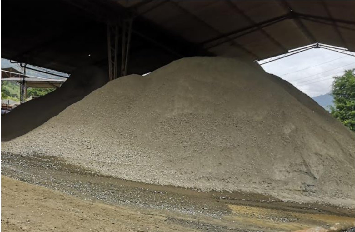
Ilustración 3. Acopio de base granular
