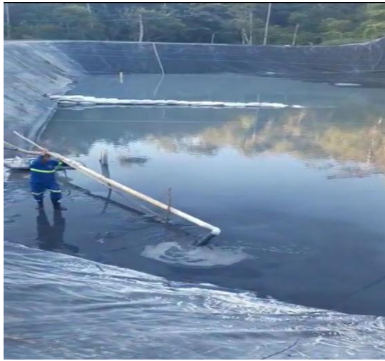
Figura 14. Piscina de tratamiento primario
