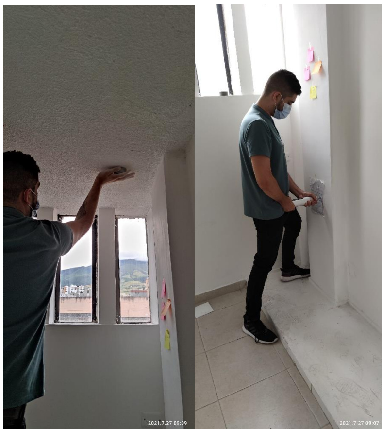
Figura 7 Ensayo de esclerómetro Tomado de: Elaboración propia
