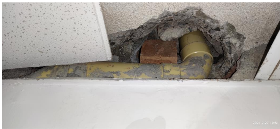
Figura 3 Perforación en losa de contrapiso
