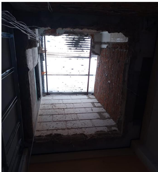
Figura 5 Demolición parcial de losas Tomado de: Elaboración propia
