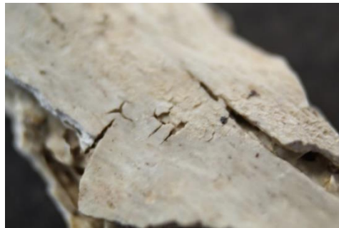
Figura 70. Grietas y fisuras.
