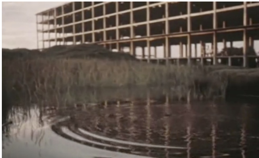
Fig. 3. Un edificio en construcción ( Rapsodia en Bogotá , José María Arzuaga, 1963).
