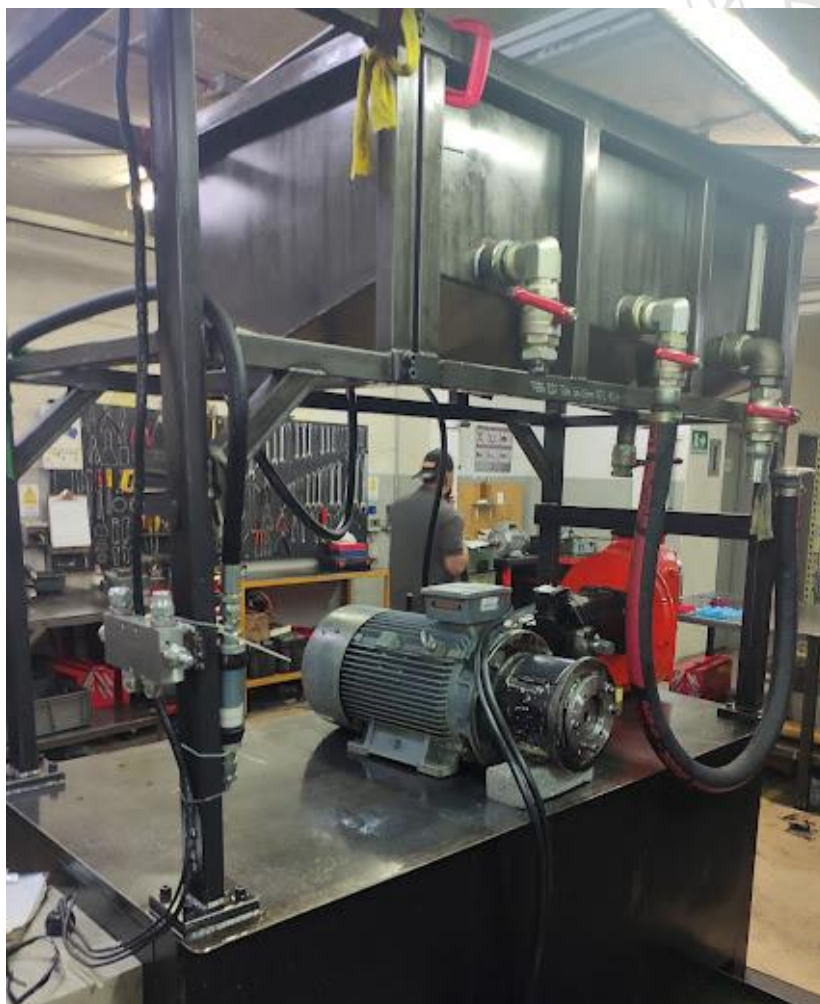
Ilustración 37. Banco de pruebas reorganizado con tanque aéreo implementado.
