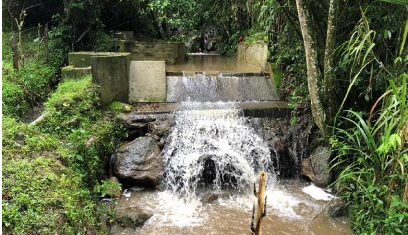
Foto 4. Bocatoma Acueducto Asociación de Usuarios de Acueducto y/o Alcantarillado El Hatillo. Nota: Fuente propia.
