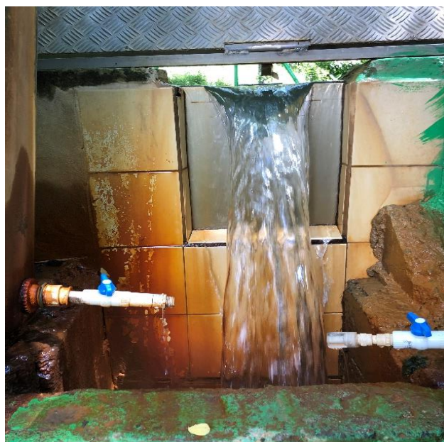
Foto 7. Vertedero triangular y zona de dosificación de coagulante. Nota: Fuente propia.
