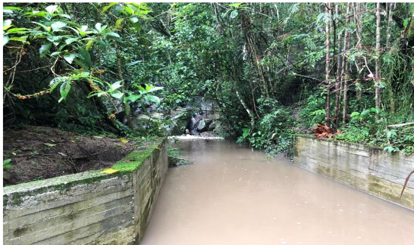
Foto 5. Bocatoma Acueducto Asociación de Usuarios de Acueducto y/o Alcantarillado El Hatillo en época invernal. Nota: Fuente propia.
