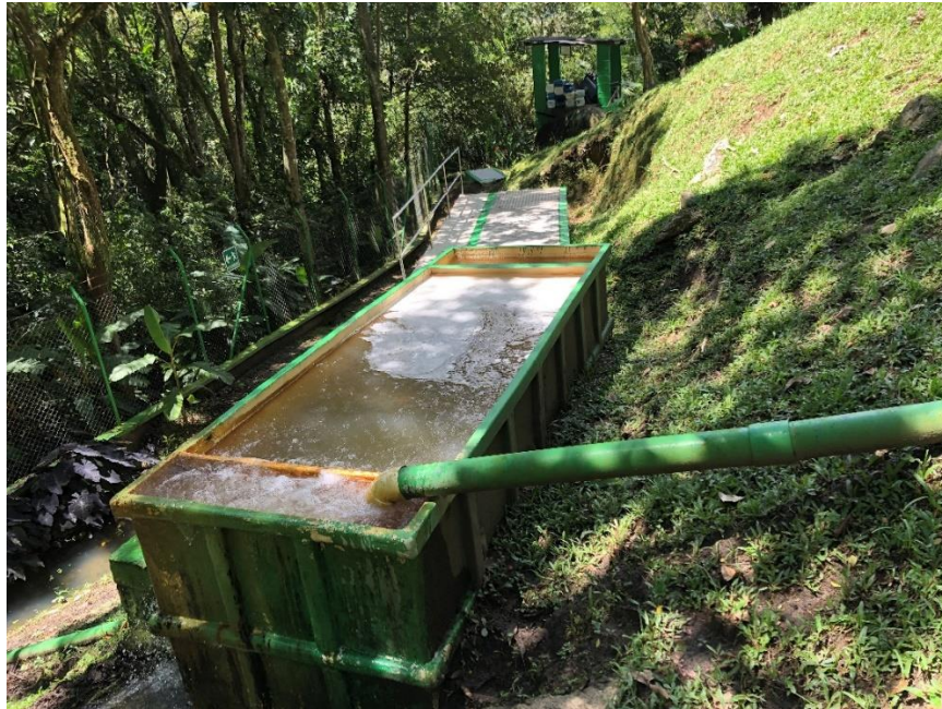
Foto 8. Desarenador. Nota: Fuente propia.
