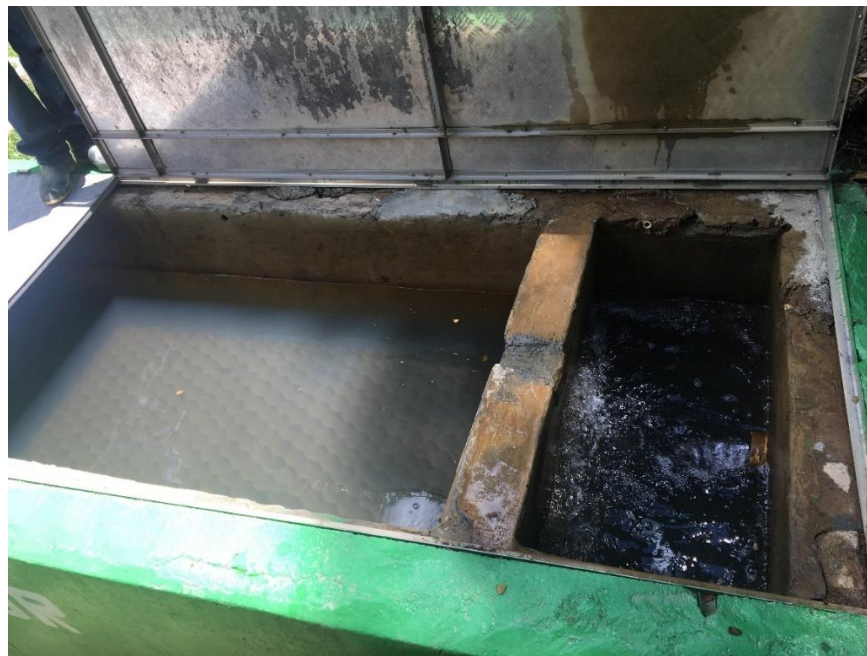
Foto 12. Sedimentador con paneles tipo colmena. Nota: Fuente propia.
