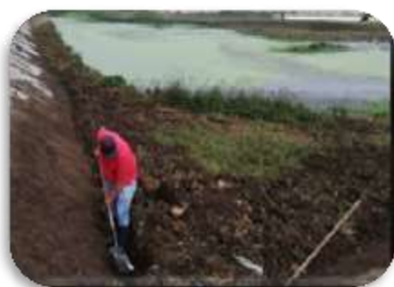
Figura 7. Remoción de lodos secos
