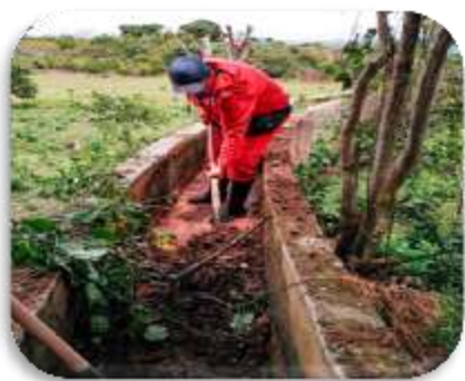
Figura 8. Limpieza de canales
