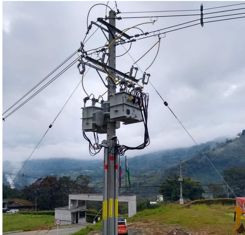
Figura 17. Montaje de los transformadores 1 y 2.
