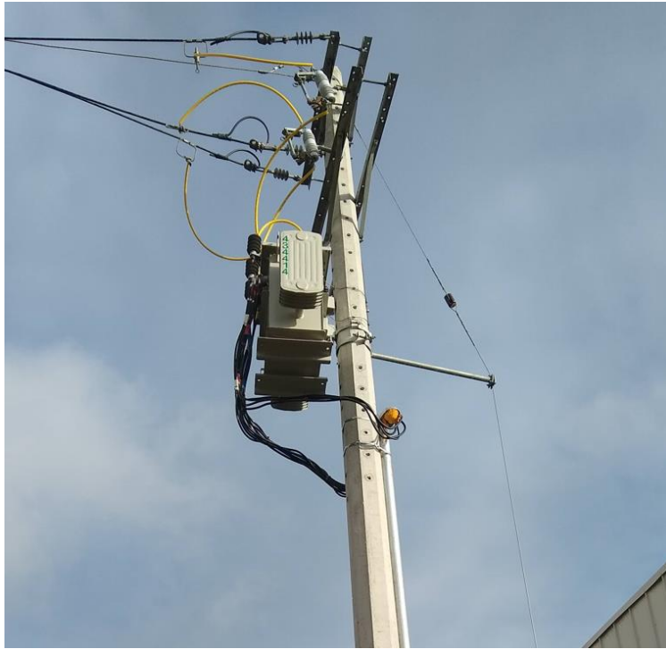
Figura 18. Montaje del transformador 3.
