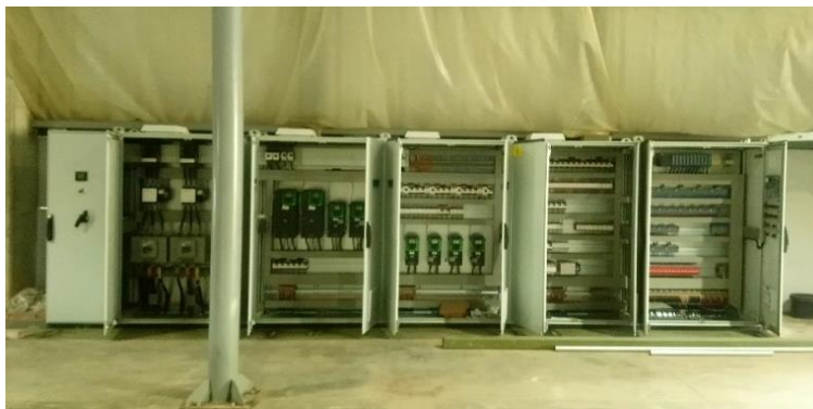
Fig. 4. Tablero de potencia y control preparación. ML dedicado a toda la zona de preparación, dónde se alista la materia prima para la extrusión y corte.
