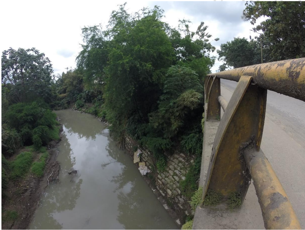
Figura 17. Cara Oriental del Puente de San Fernando del rio Apartadó.
