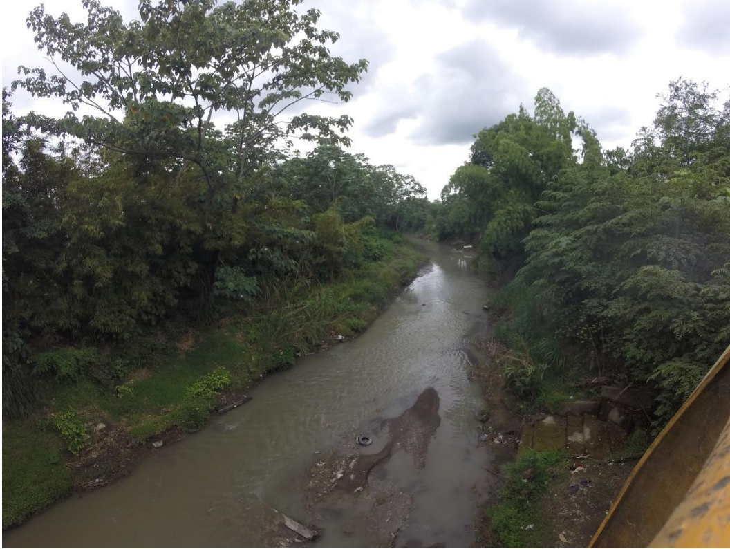
Figura 16. Cara Occidental del puente de San Fernando del río Apartadó.
