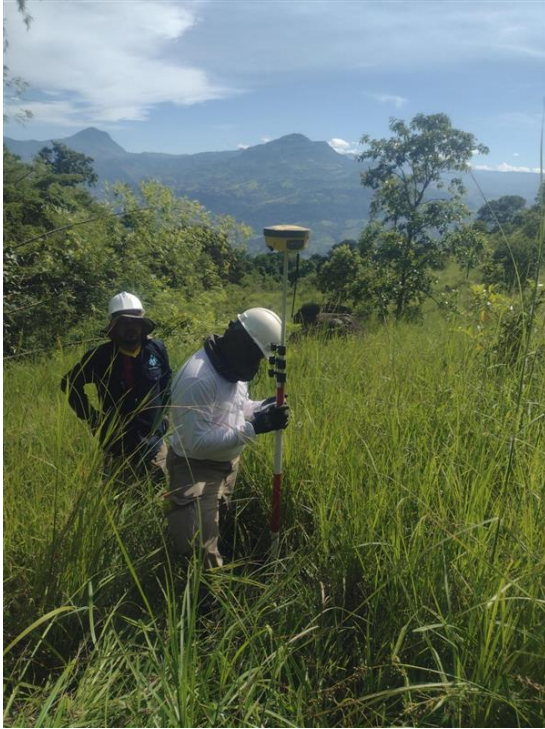
Figura 10. Replanteo topográfico de postes para cables de media tensión.
