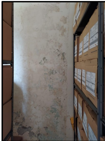
Ilustraciones 25 y 26. Humedad en paredes y techo Alcaldía de Venecia.
