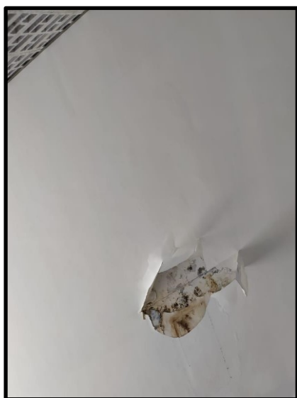
Ilustraciones 25 y 26. Humedad en paredes y techo Alcaldía de Venecia.
