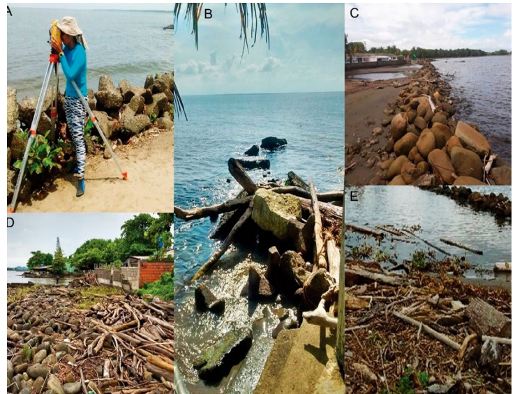
Figura 5.3 Principales características topográficas de punta Las Vacas. A) Espolón ubicado al frente del estadero “Pedro P”; B) Escombros; C) Enrocado dentro de capitania de puerto; D) y E) Escombros localizados en las zonas aledañas a los locales comerciales. (Fuente: Elaboración propia - Componente Topografía Batimétrica).
