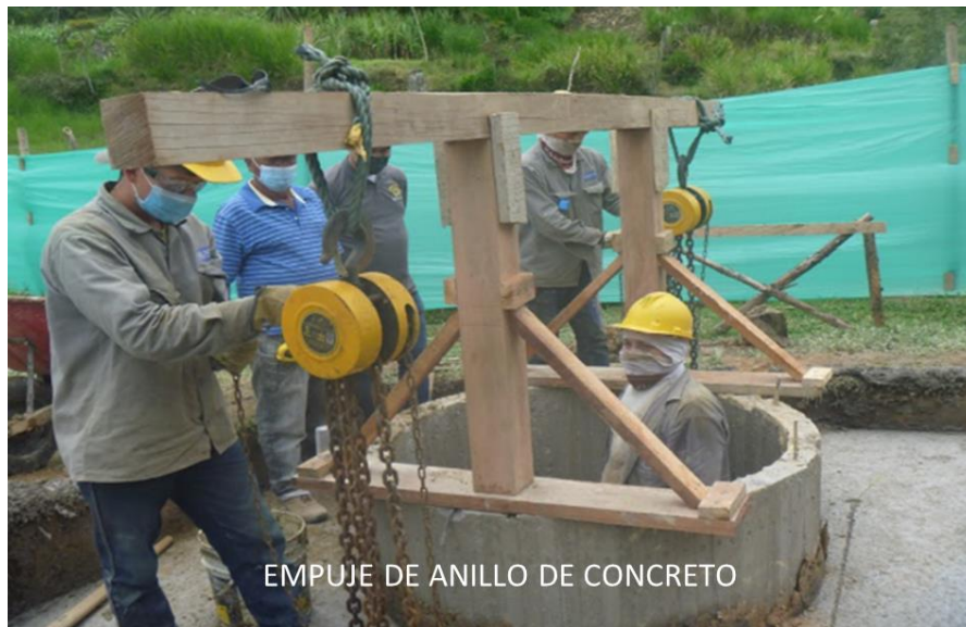
Figura 9 Empuje de anillos de concreto. Elaboración propia.
