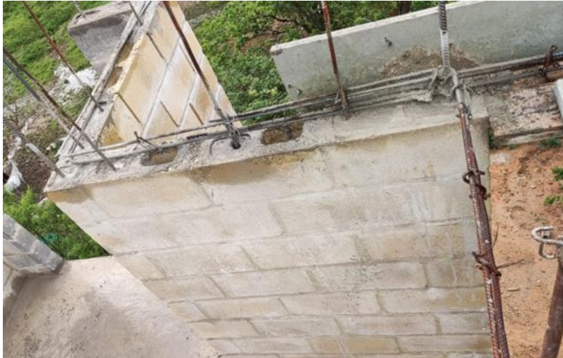
Ilustración 5. Vaciado de muros
