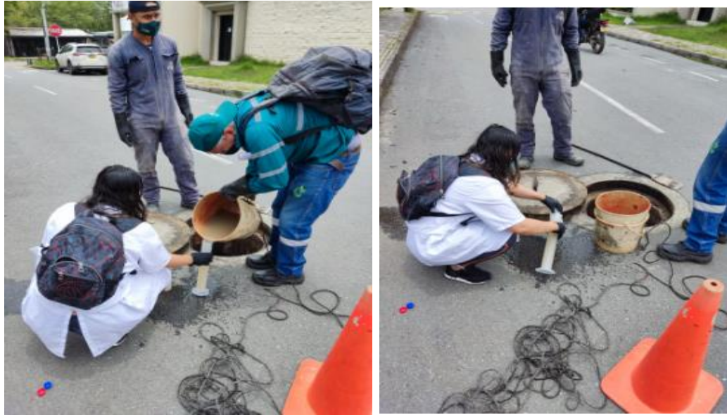
Figura 2. Toma de muestras de la red de Alcantarillado de Marinilla
