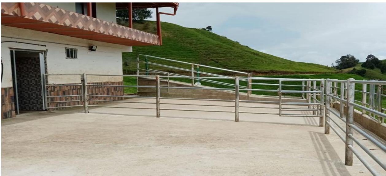
Fig. 7 Sitio a ubicar módulos FV.
