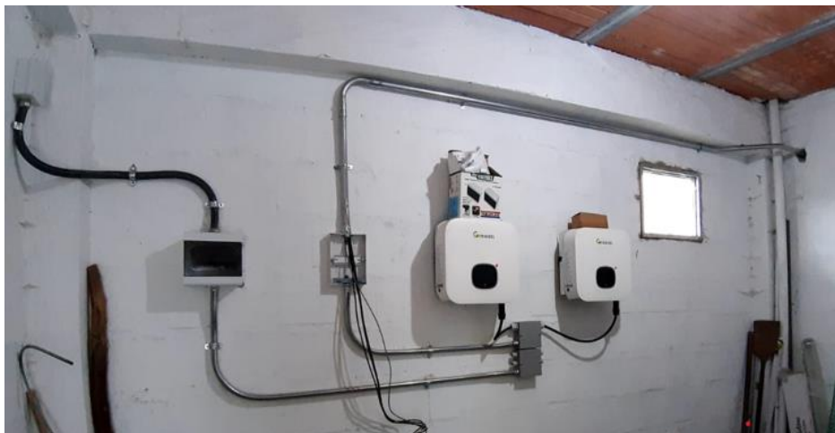
Fig. 11 Conexión DC/AC del SFV.
