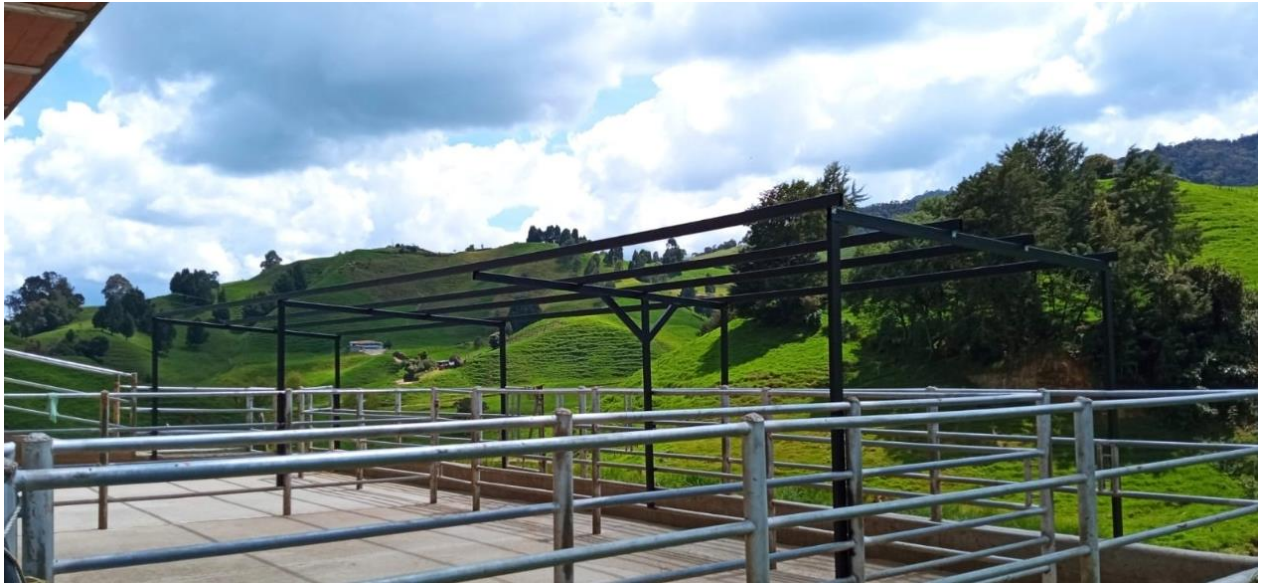
Fig. 8 Estructura para ubicación de módulos FV.
