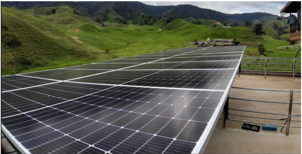
Fig. 9 Montaje de módulos FV.
