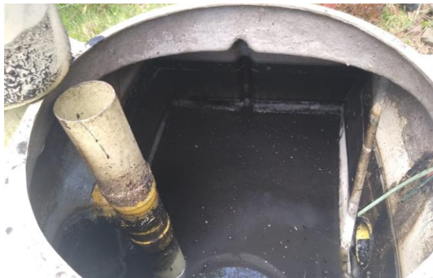
Fotografía 3. Utilización de lodos activados de un filtro anaerobio de flujo ascendente.
