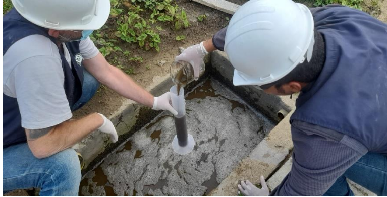
Fotografía 4. Toma de muestras en caja de inspección.
