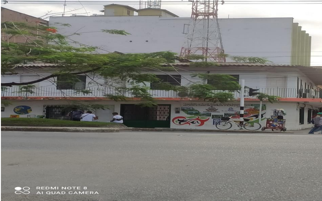
Figura 2 Fachada de la Personería de Apartadó
