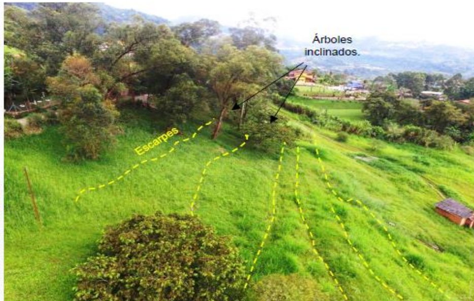
Imagen. 12. Sitio crítico K4+630, movimientos diferenciales del terreno (Reptación)
