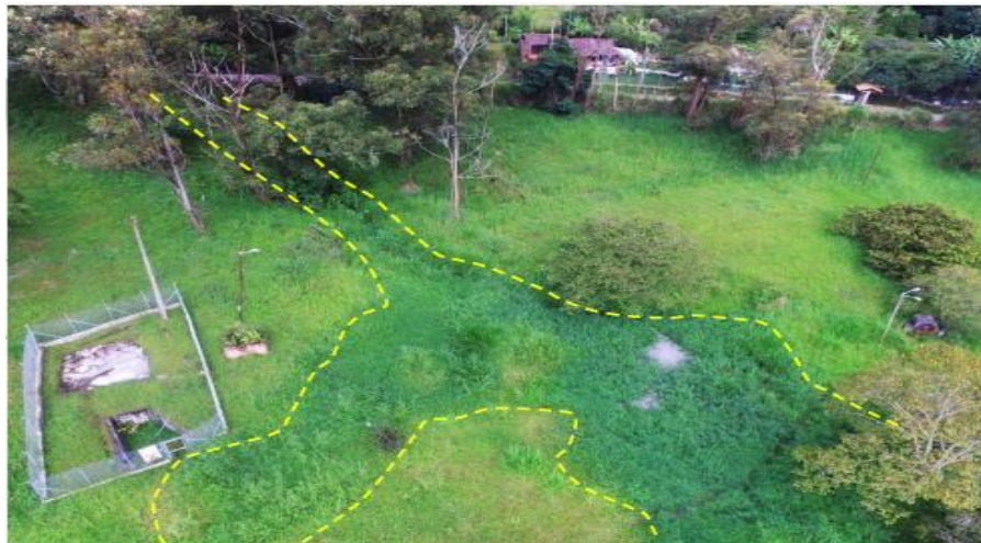
Imagen. 13. Sitio crítico K4+630, Escurrimiento de agua sin un adecuado manejo hidráulico, situación que incide en los movimientos diferenciales del terreno (Reptación)
