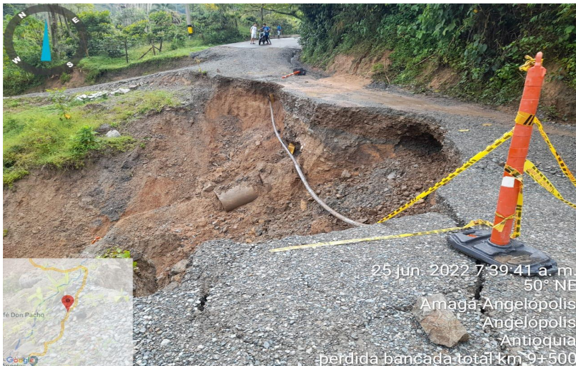
Imagen. 19 Perdida de banca total zona critica k9+500.
