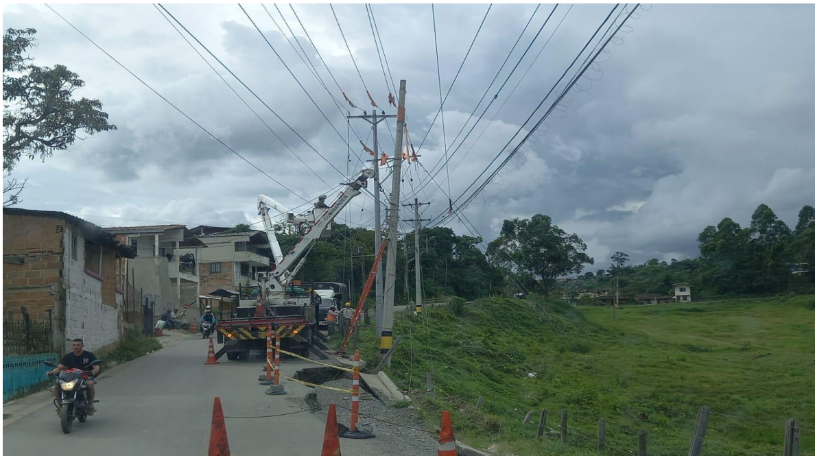
Imagen. 11 Pérdida de calzada de pavimento por asentamientos diferenciales en sitio crítico.
