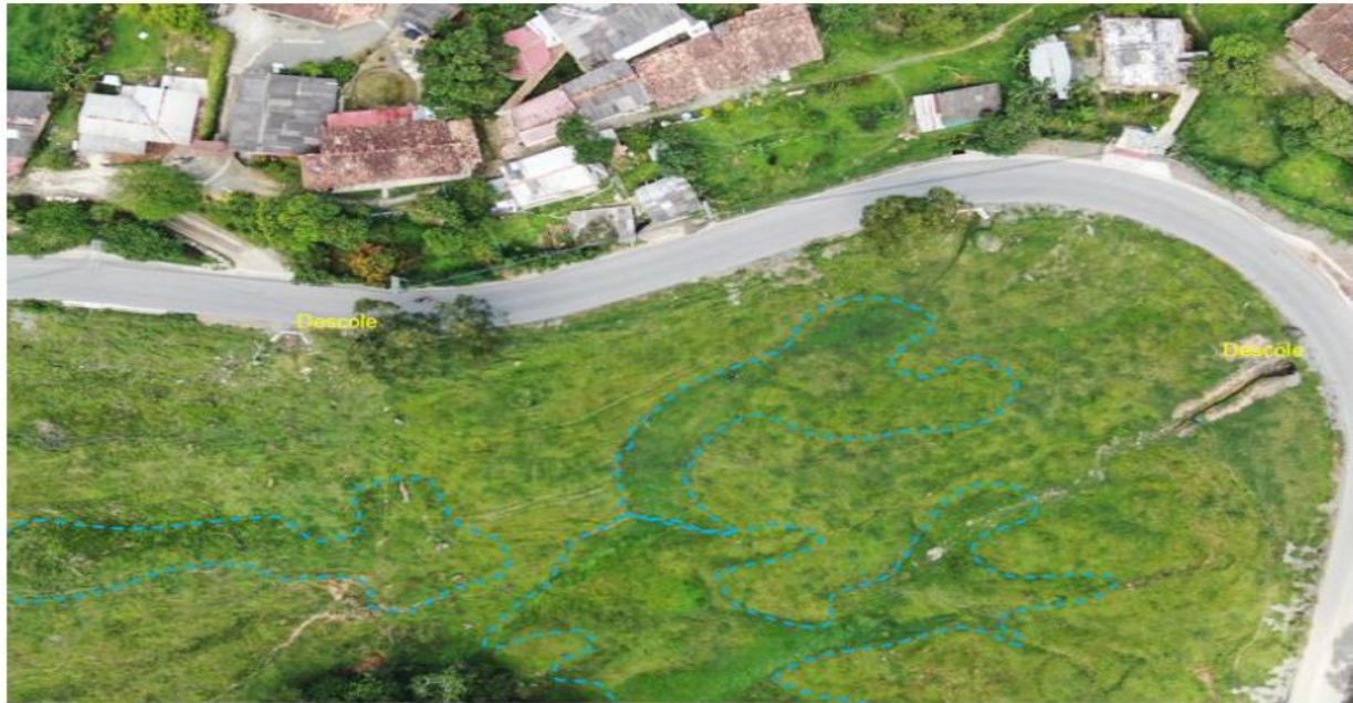
Imagen. 10 Zona de descarga de todas las aguas de escorrentía de las laderas circundantes. Sitios críticos K3+900 y K3+950.
