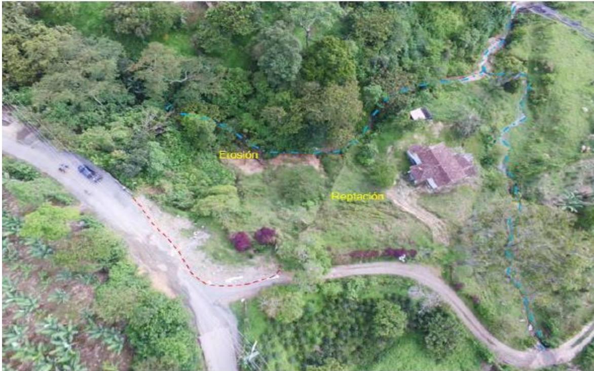
Imagen. 18 Sitio crítico K9+540, movimientos diferenciales del terreno (Reptación).
