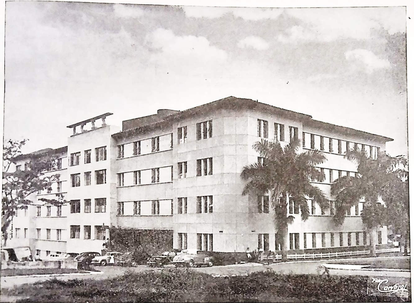
Moderno edificio de la Clínica León XIII del ICSS.
