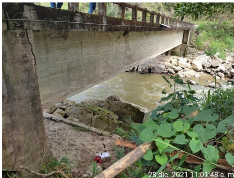
Figura 9. Puente Río Nare (km 16+630).
