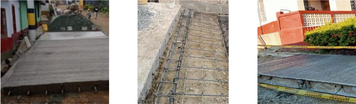
**Ilustración 6.** *Acabado y texturizado de pavimento*
