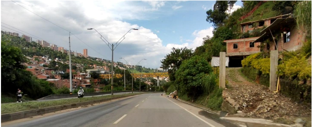
Figura 28. Acceso a predio. Fuente: elaboración propia.
