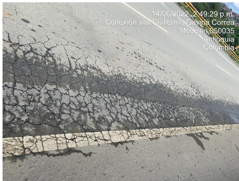
Figura 45. Piel de cocodrilo. Fuente: elaboración propia
