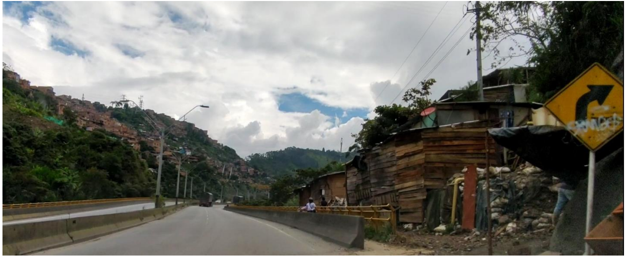
Figura 26. Asentamientos cercanos a la vía. Fuente: elaboración propia.
