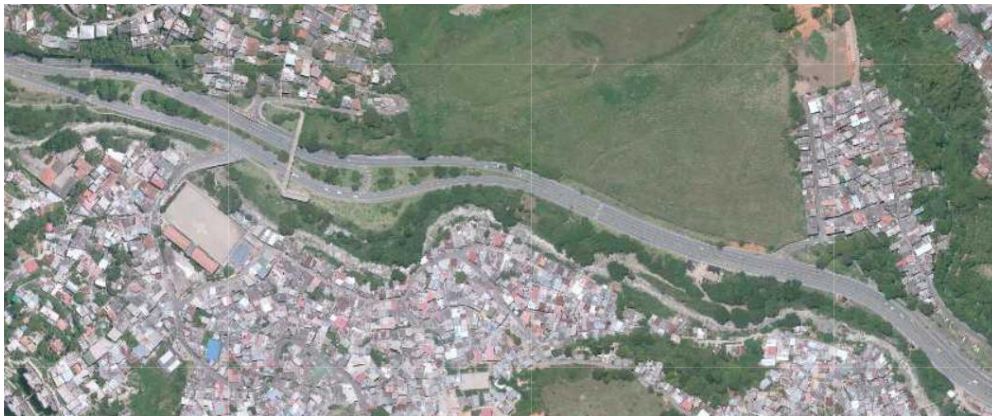
Figura 11. Sección no coincidente entre vía construida y plano de diseño. Fuente: MapGIS.
