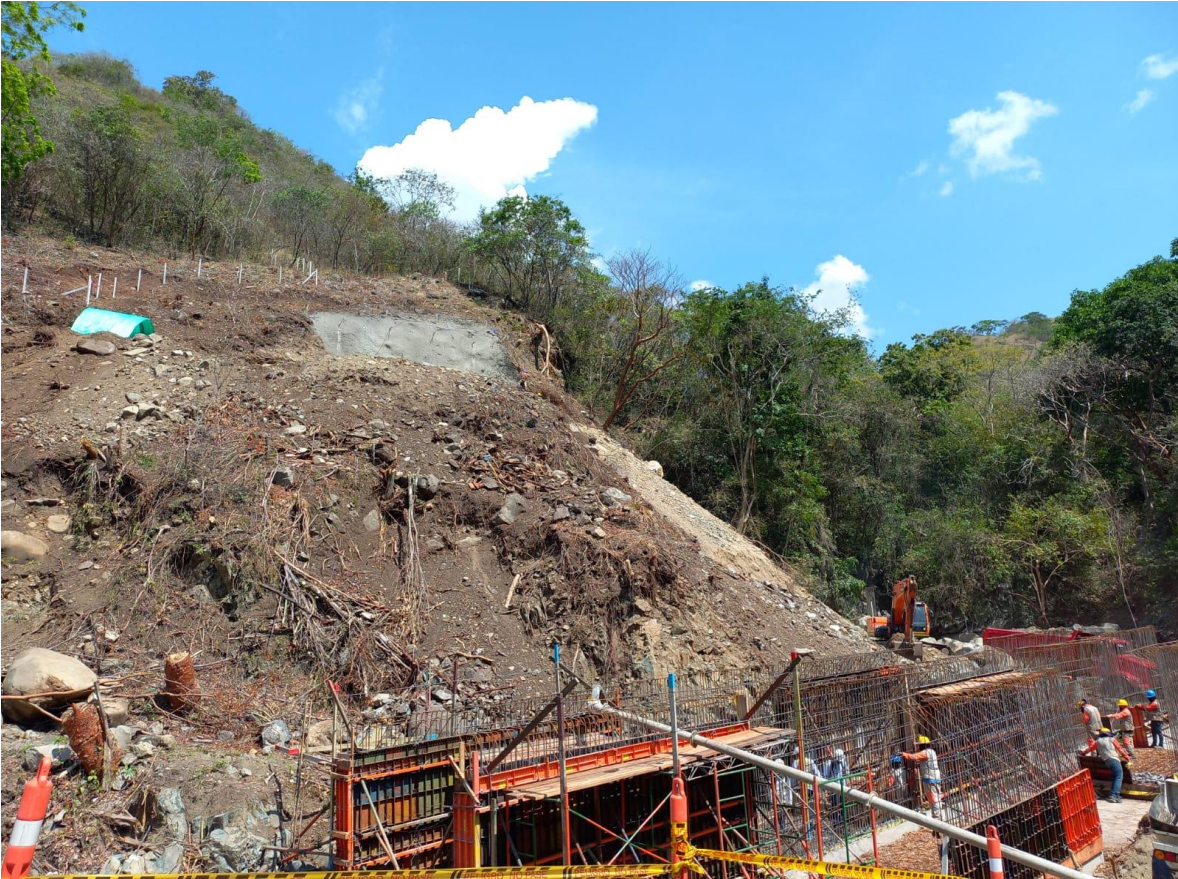
Ilustración 5 Obra box coulvert
