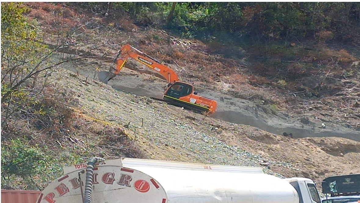
Ilustración 3 Apertura de portal del túnel 3 sector 1
