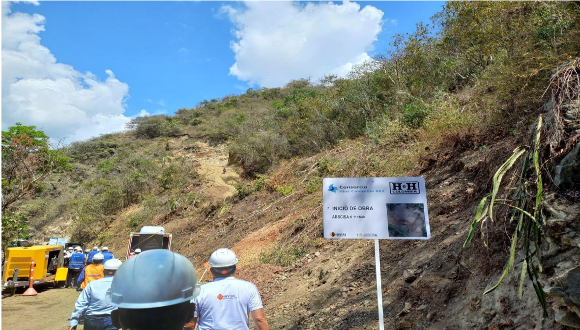
Ilustración 4 Inicio de obras del sector 2
