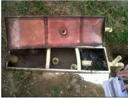
Figura 12. Interior del pozo
