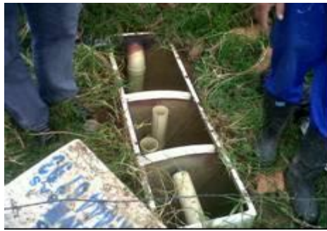
Figura 14. Interior pozo séptico
