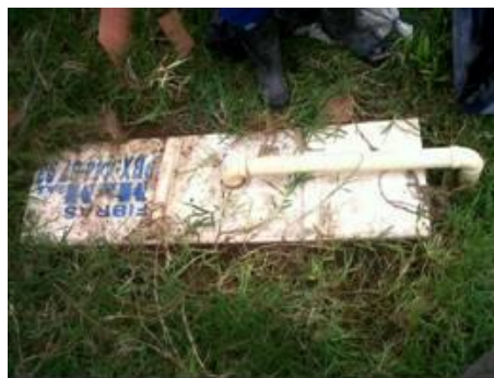
Figura 16. Registro de inspección del pozo
