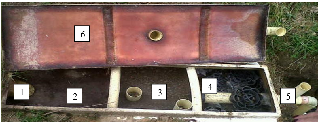
Figura 17. Componentes del pozo séptico prefabricado
