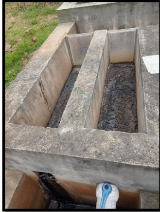
Ilustración 11: Desarenadores
