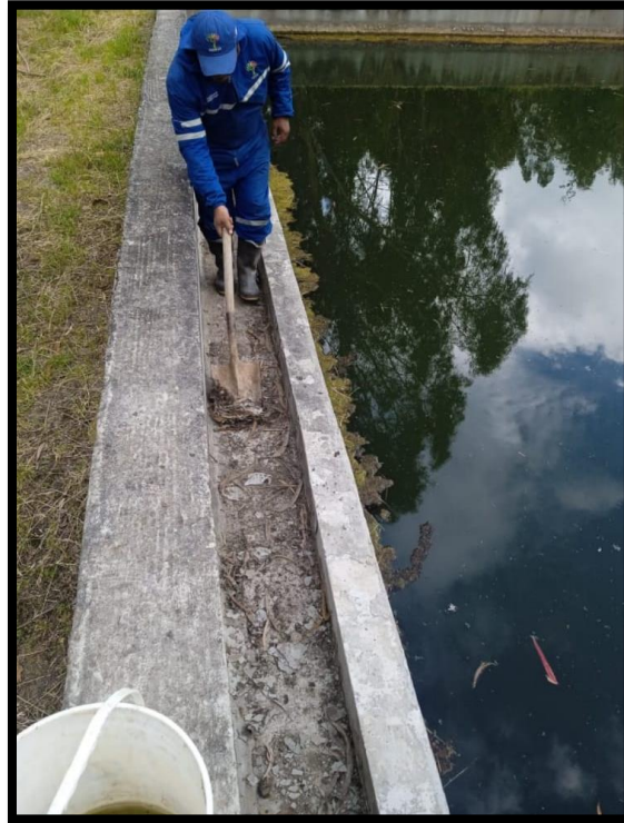
Ilustración 15: Mantenimiento reactor de lodos activados zona externa
