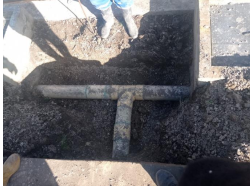
Ilustración 24: Cambio de tubería entrada reactores UASB
