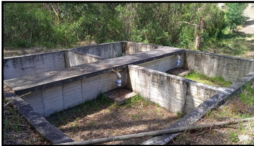
Ilustración 8: Lechos de secado
