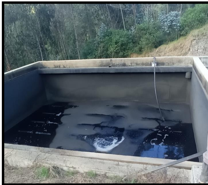
Ilustración 14: Mantenimiento de Reactor de lodos activados zonas internas
