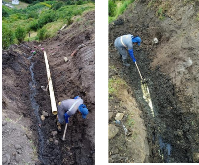
Ilustración 22: Cambio de tubería de conducción de lixiviados
