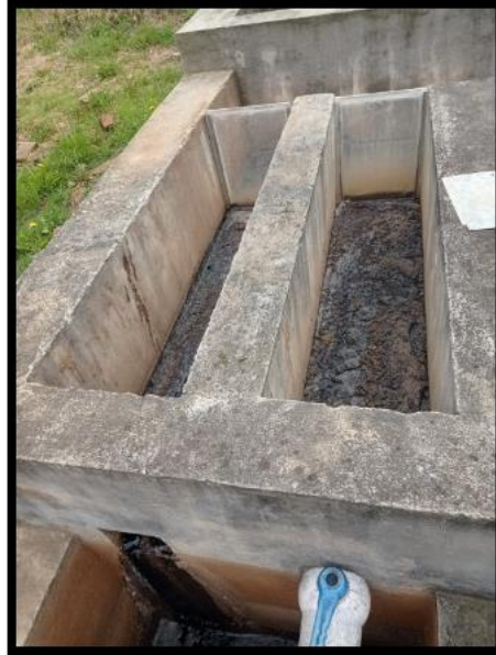
Ilustración 4: Desarenadores
