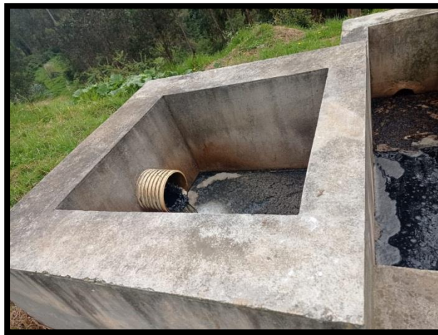
Ilustración 10: Entrada a la planta
