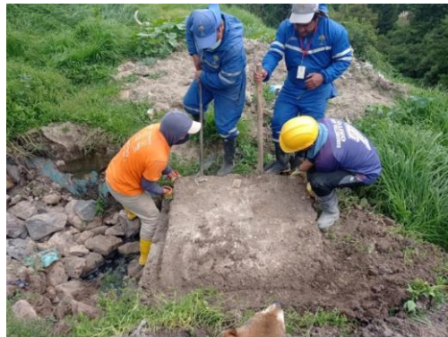
Ilustración 23: Cambio de tubería de entrada a la PTAL
