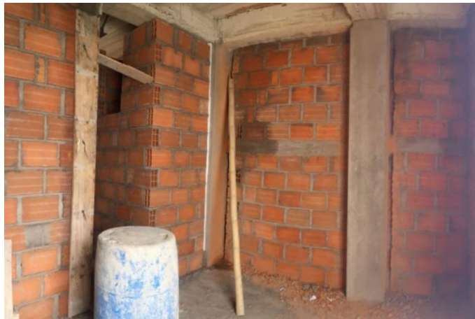
Figura 9. Registro fotográfico, Construcción de muros de mampostería.
