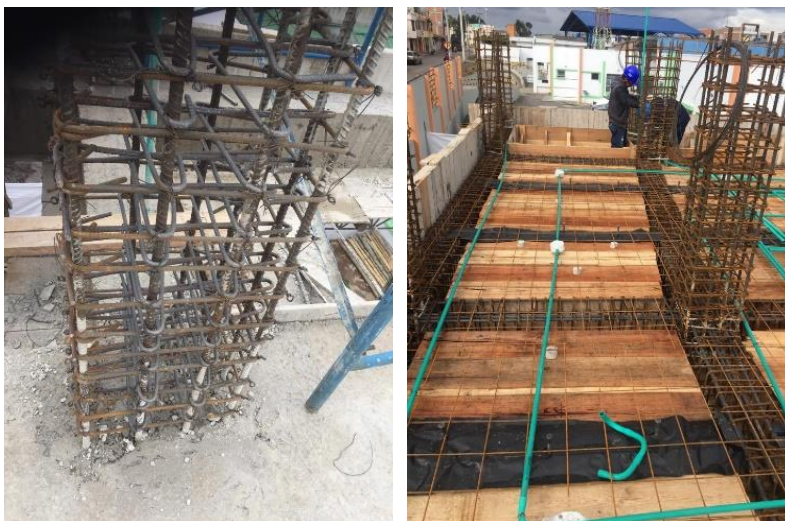
Armado en acero de algunos elementos estructurales
