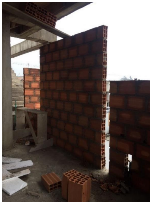
Figura 10. Registro fotográfico, construcción muros de mampostería.
