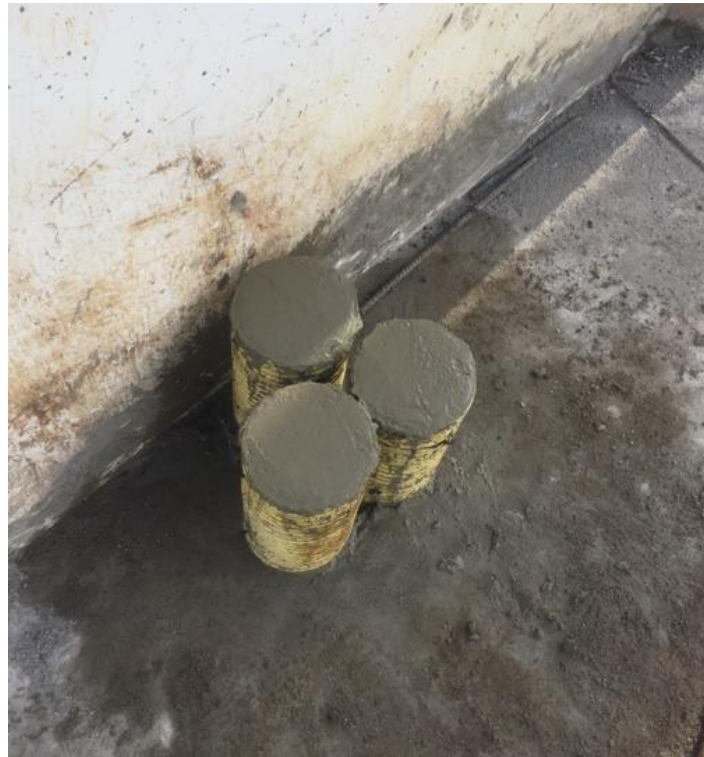
Figura 13. Registro fotográfico, Toma de muestra después del vaciado de concreto
