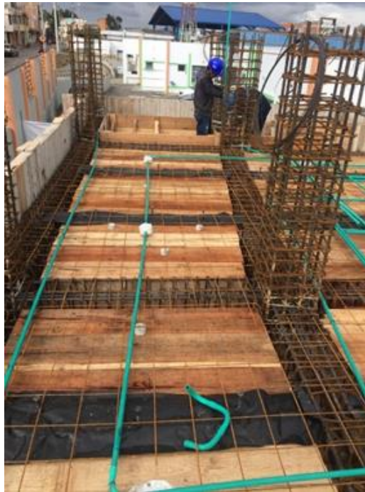
Figura 7. Registro fotográfico, instalación de tubería eléctrica
