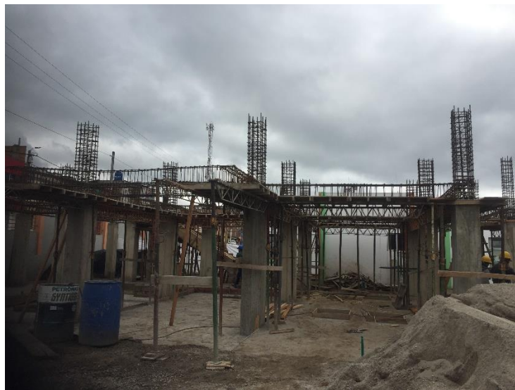
Figura 3. Registro fotográfico, Armado de acero estructural, vigas aéreas segundo nivel
