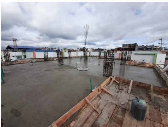
Vaciado de concreto en losas de la edificación
