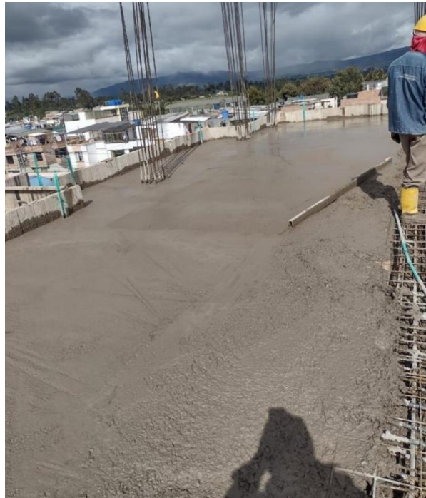
Figura 2. Registro fotográfico, vaciado de concreto en losa tercer nivel
