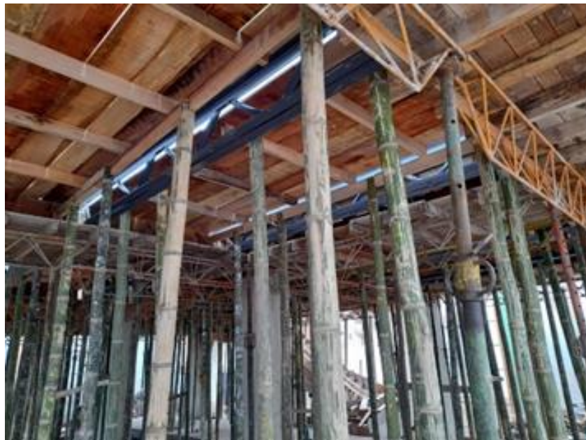
Figura 22. Registro fotográfico, verificación de armado de encofrado de losa de entepiso
