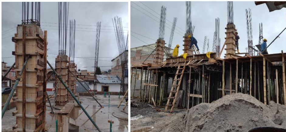
Armado y vaciado de concreto de las columnas de la edificación
