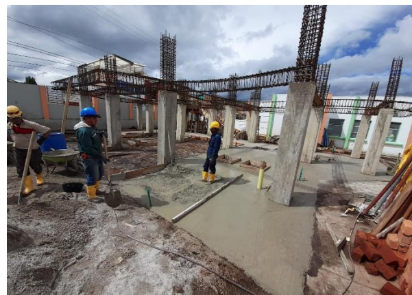
Vaciado de concreto en losas de la edificación
