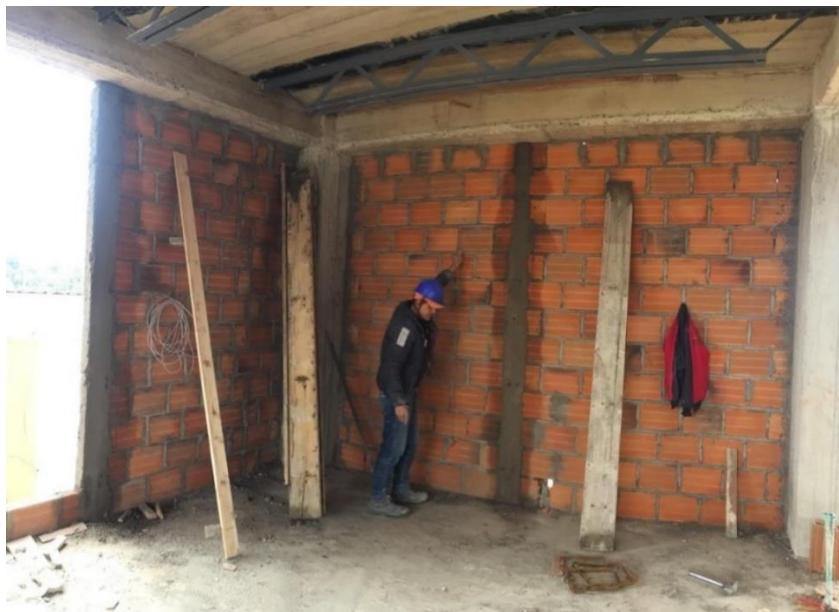
Figura 18. Registro fotográfico, revisión construcción muros de mampostería (toma de plomada)
