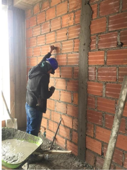
Figura 17. Registro fotográfico, revisión construcción de muros mampostería (toma de plomada)
