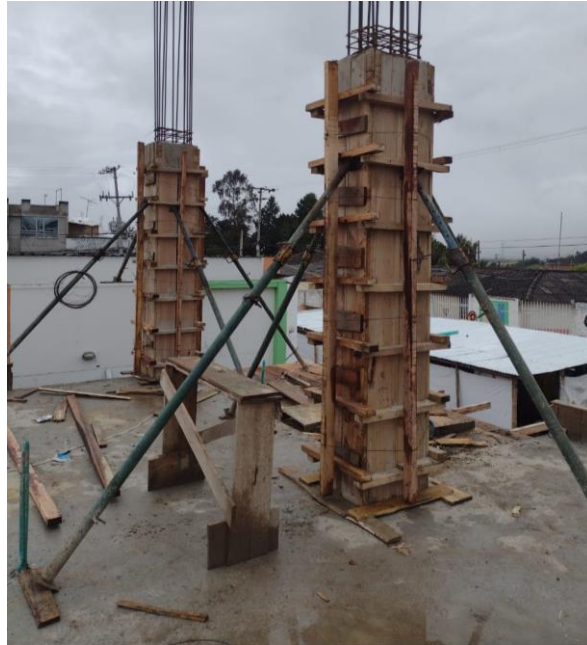
Figura 5. Registro fotográfico, Encofrado de columnas
