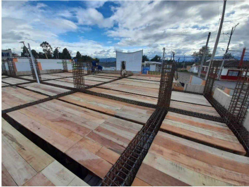
Figura 22. Registro fotográfico, verificación de armado de encofrado de losa de entepiso
