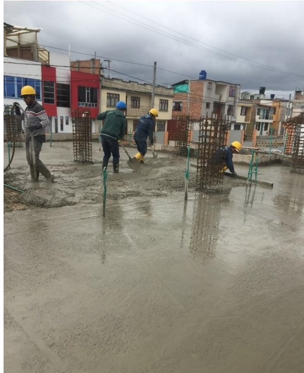
Figura 1. Registro fotográfico, vaciado de concreto en losa del segundo nivel
