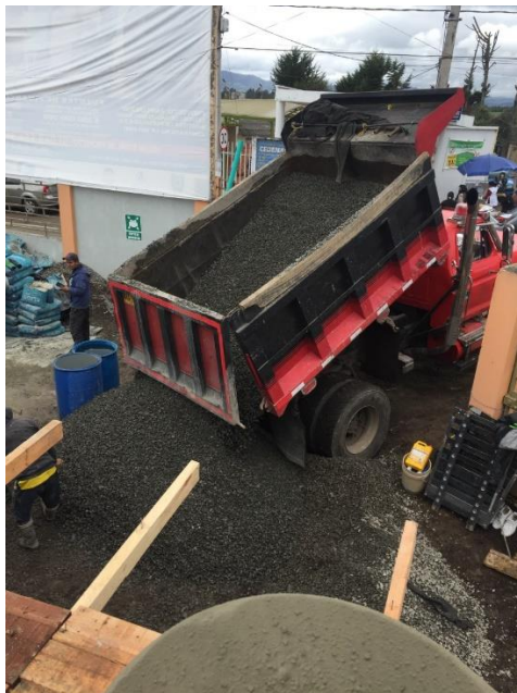
Figura 11. Registro fotográfico, control de llegada de material
