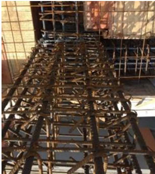
Figura 4. Registro fotográfico, Armado de acero estructura columna.
