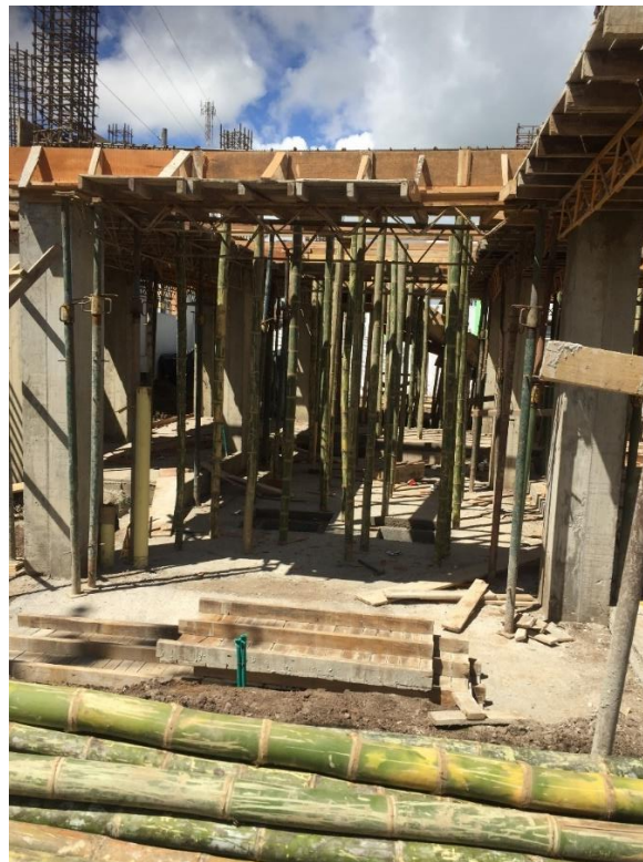
Figura 6. Registro fotográfico, Encofrado de losa de entrepiso
