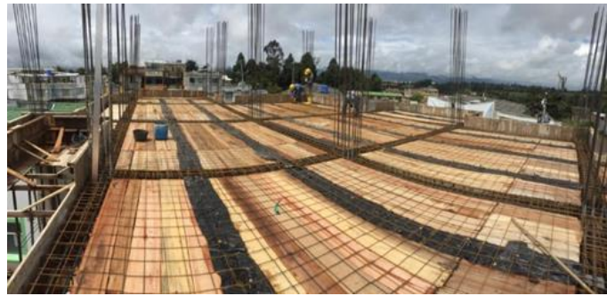
Encofrado losa de entrepiso de la edificación
