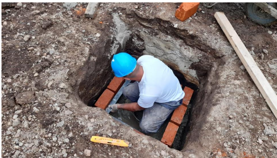
Figura 8. Registro fotográfico, construcción de cajillas, instalación hidrosanitaria.
