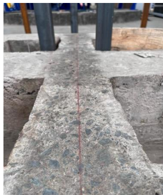
Figura 15. Marcación de línea de centro de maquina por medio una cimbra.
