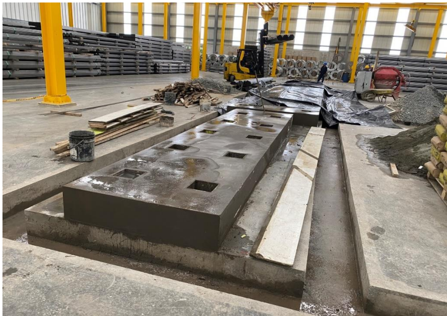
Figura 13. Pedestal para Formadora de Tubos KBD76
