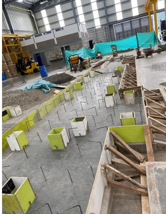
Figura 12. Inicio obra civil para Formadora de Tubos KBD76
