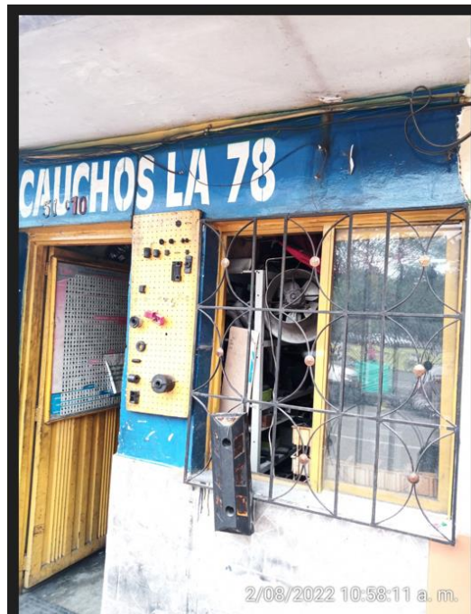
Figura 21. Instalación que requiere cambio de tarifa.
