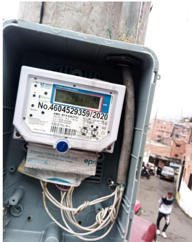
Figura 3. Macromedidor con señales manipuladas.
