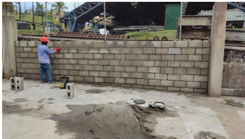
Foto 7 Inicio muro mampostería en bloque Fuente: Elaboración propia
