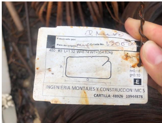
Foto 5 Estribos figurados #3 Fuente: elaboración propia
