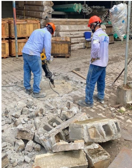
Foto 2 Excavación mecánica de zapatas Fuente: elaboración propia
