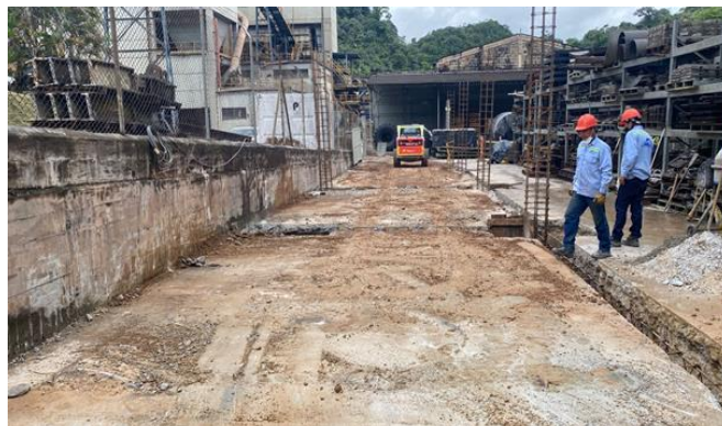
Foto 1 Demolición placa piso y excavaciones Fuente: elaboración propia
