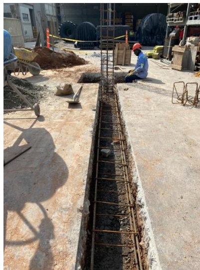
Foto 3 Armado de acero para vigas de piso y zapatas Fuente: elaboración propia
