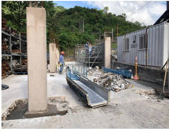
Foto 6 Columnas y formaleta proyecto ampliación bodega Fuente: elaboración propia
