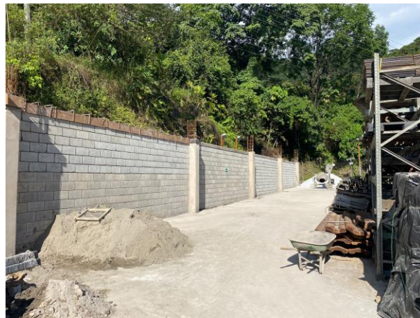
Imagen 4 Encofrado viga aérea Fuente: elaboración propia
