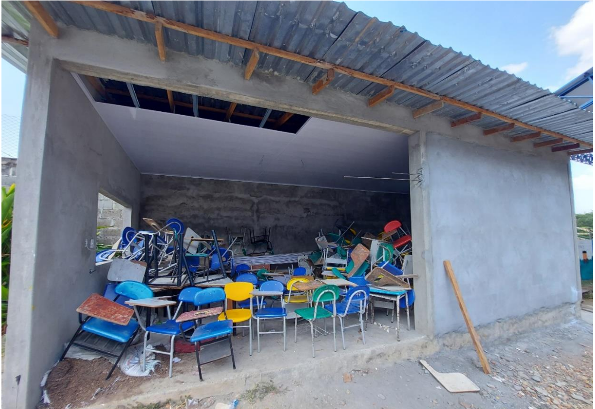
Figura 17. Cuarto de sillas inservibles para posible ubicación del sitio de almacenamiento central
