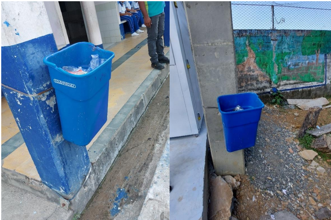
Figura 9. Recipientes ubicados en las columnas de la sede educativa
