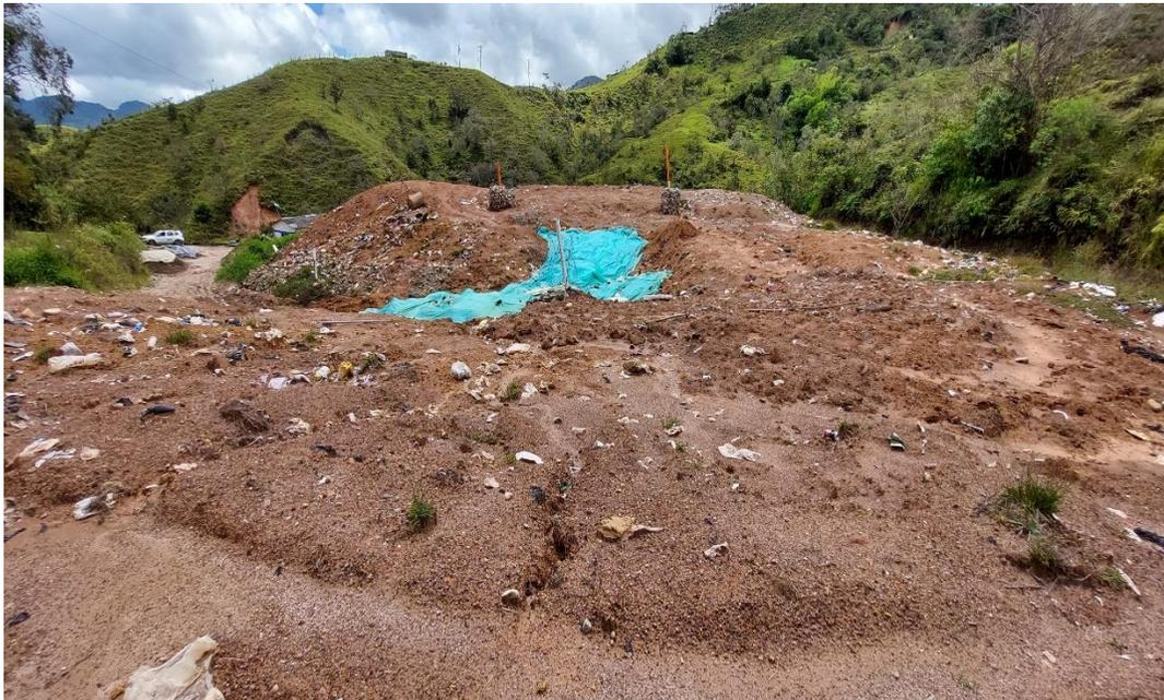
Los rellenos sanitarios deben contar con adecuados filtros verticales en el relleno sanitario de Alejandría se encontró que cuenta con filtros contruidos en piedra de canto rodado, con malla eslabonada y tubería en PVC perforada. En general se encuentran en buen estado, sin embargo, se evidencia que han unas chimeneas que deben ser verticalizadas, con el fin de garantizar la adecuada evacuación de los gases producidos por la descomposición de los residuos sólidos dispuestos.
