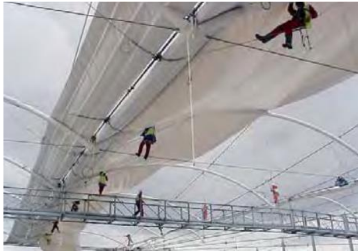
Imagen 13 Trabajo en altura durante la instalación de cubierta
