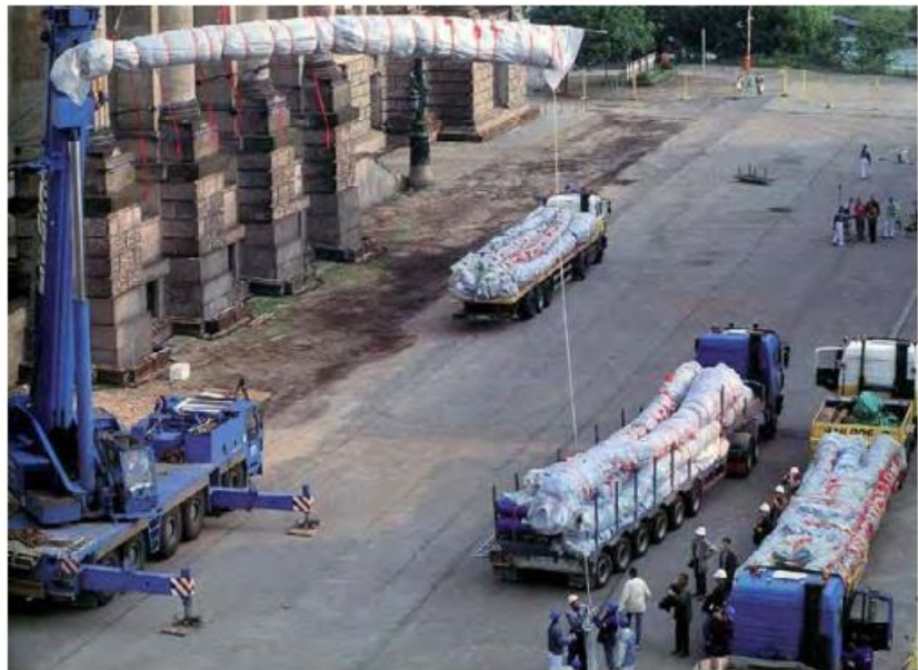
Imagen 14 Despliegue en altura y transporte vertical de membranas.
