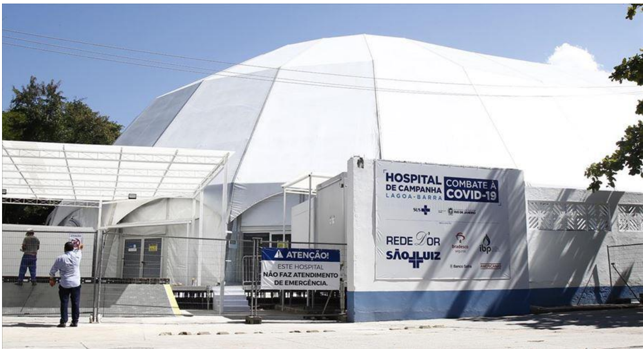
Imagen 1 Ejemplo de tensoestructura en la construcción de hospital de campaña durante la emergencia del Covid-19
