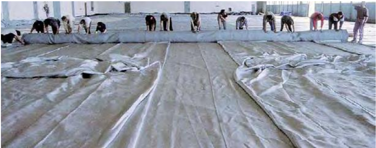
Imagen 12 Despliegue de membrana en etapa de remontaje
