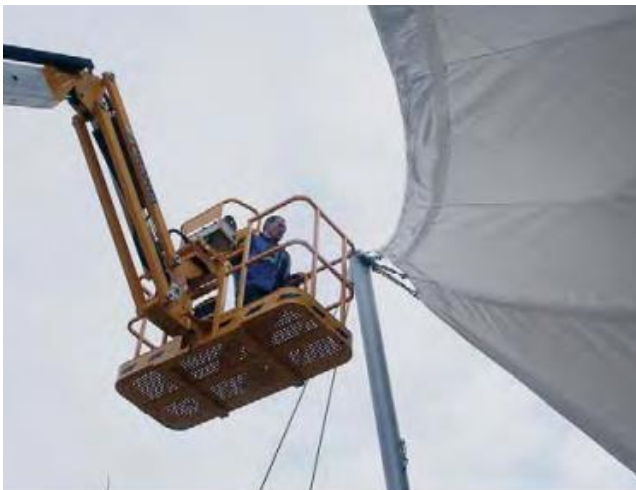
Imagen 9 Plataformas de trabajo para actividades en altura.
