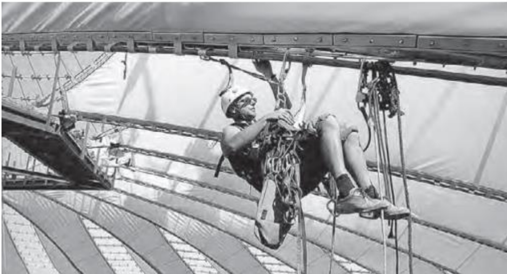
Imagen 6 Trabajador suspendido durante la instalación de una membrana para cubierta
