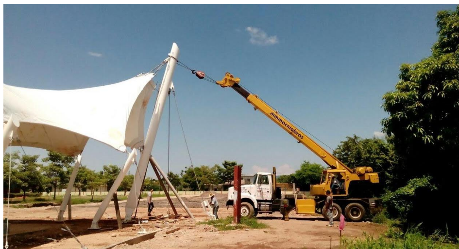
Imagen 7 Grúa empleada como elemento estabilizador temporal
