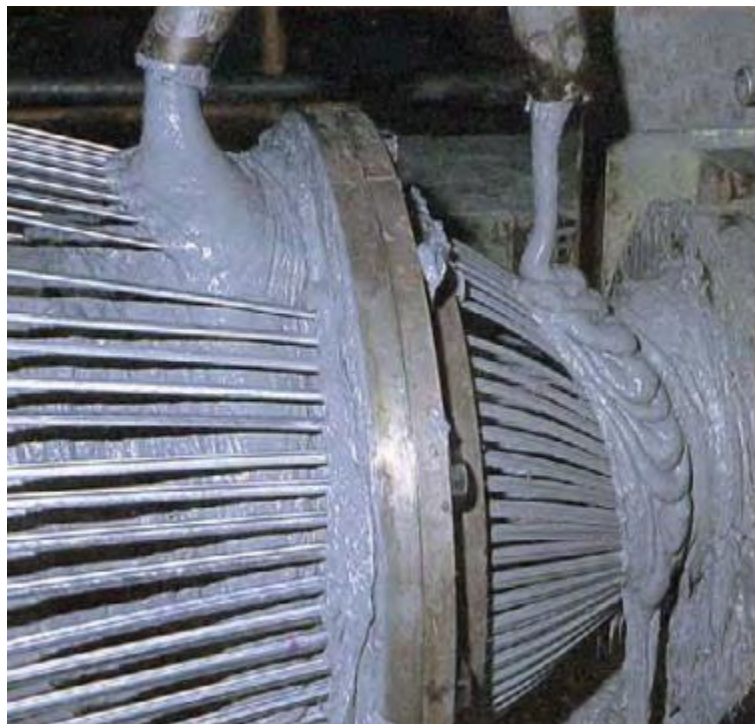
Imagen 4 Inyección de lubricante
