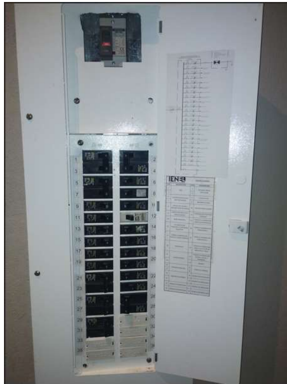
Imagen 1. Diagrama unifilar y directorio de Circuitos.
