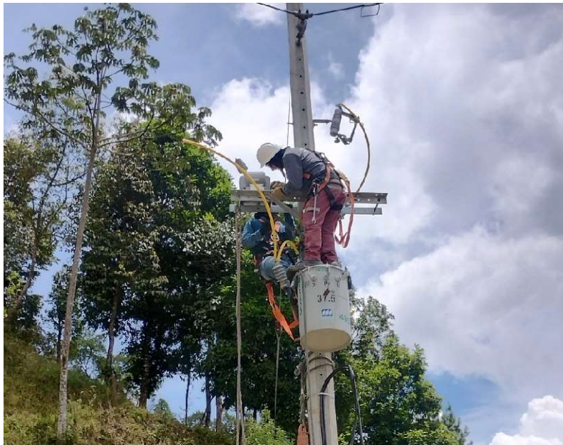
Imagen 11. Montaje de Transformador 37.5KVA de acuerdo con la Norma RA 8 – 028
