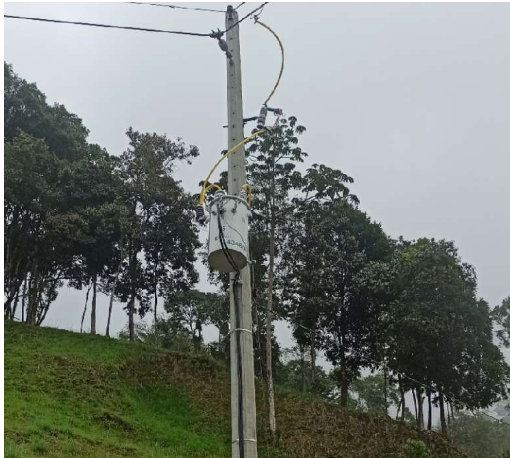
Imagen 10. Instalación Poste Inicial 25KVA
