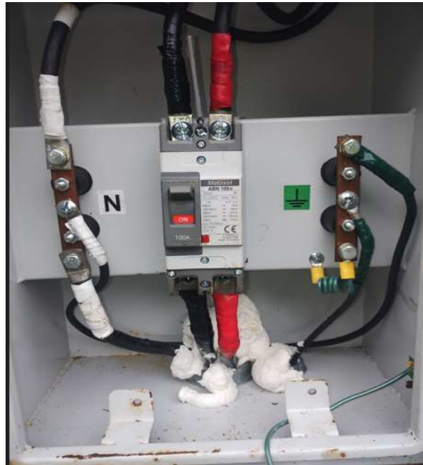
Imagen 4. Sellado de tubería del alimentador.
