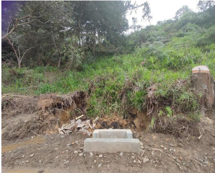
**Ilustración 38.** *Poceta de la obra transversal #2 delante de pendiente inestable en el tramo 01 La Magdalena. Fuente: informes de Consicor S.A.S.*
