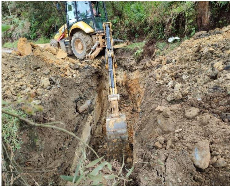
**Ilustración 9.** *Excavación para obra transversal. Fuente: informes de Consicor S.A.S.*
