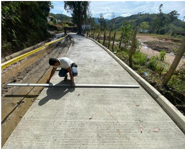
**Ilustración 44.** *Acabado final del carril pavimentado. Fuente: informes de Consicor S.A.S.*
