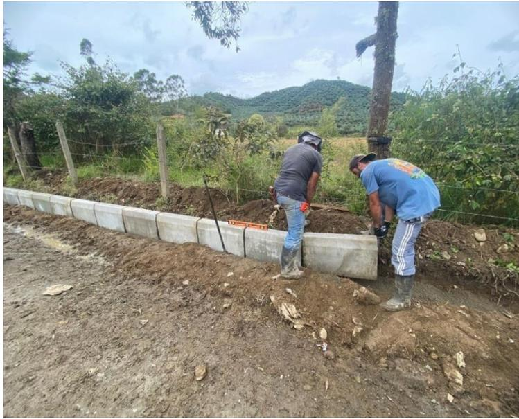
**Ilustración 25.** *Instalación de bordillos en el tramo 01 La Magdalena. Fuente: informes de Consicor S.A.S.*
