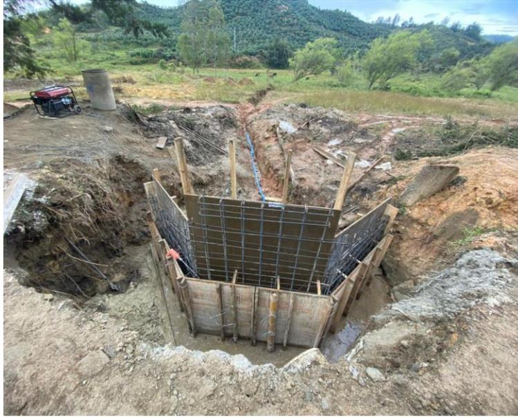
**Ilustración 33.** Armado del descole de la obra transversal #2 en el tramo 01 La Magdalena.
