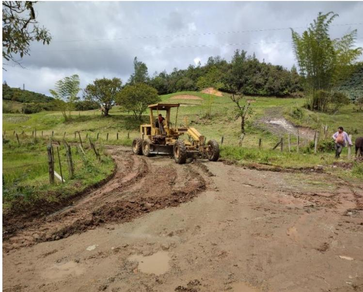
**Ilustración 13.** *Conformación de calzada existente con motoniveladora tramo 01 La Magdalena.*
