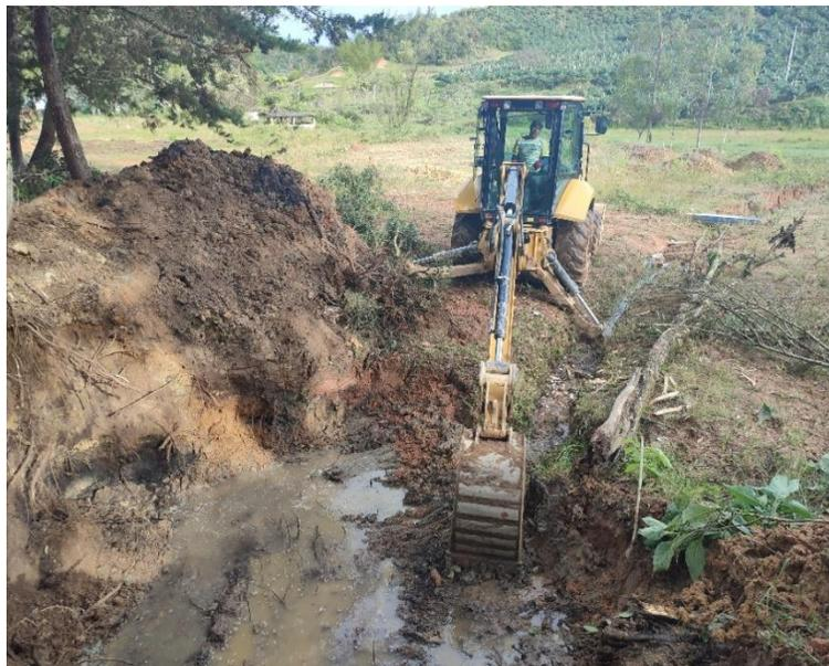
**Ilustración 29.** *Excavación del descole de la obra transversal #2. Fuente: informes de Consicor S.A.S.*
