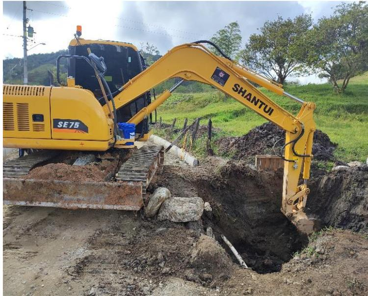
**Ilustración 28.** *Excavación de segunda poceta de la obra transversal #1. Fuente: informes de Consicor S.A.S.*
