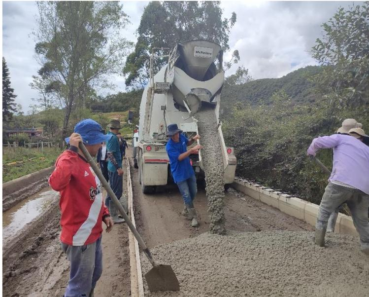
**Ilustración 41.** *Disposición del concreto tipo premezclado. Fuente: informes de Consicor S.A.S.*
