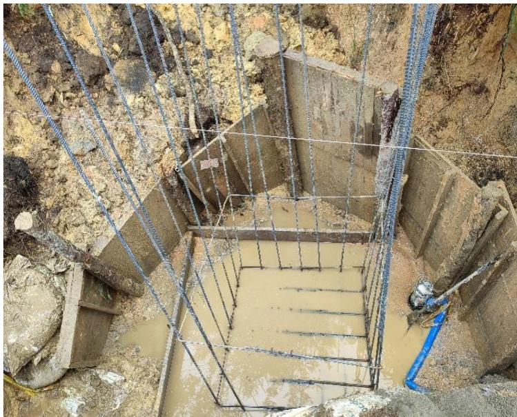
**Ilustración 34.** Armado de poceta de la obra transversal #2 en el tramo 01 La Magdalena.
