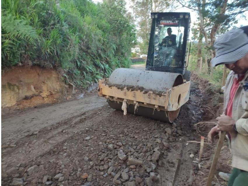
**Ilustración 20.** *Compactación de subbase granular en el tramo 01 La Magdalena. Fuente: informes de Consicor S.A.S.*
