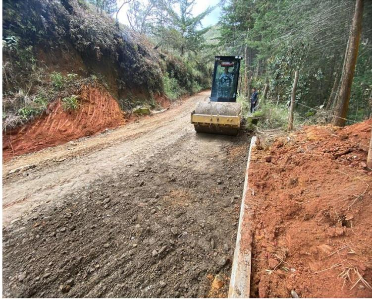
**Ilustración 22.** Compactación de subbase granular en el tramo 02 La Enea. Fuente: informes de Consicor S.A.S.
