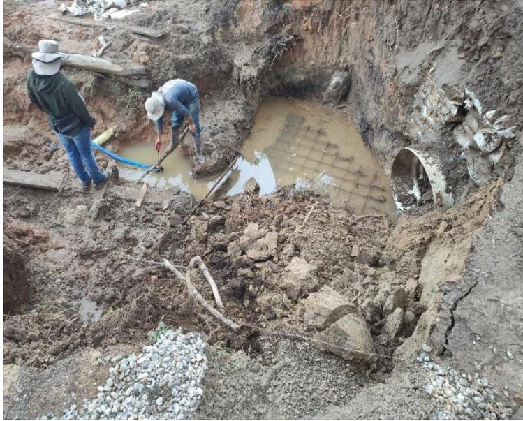
**Ilustración 45.** *Derrumbe del suelo hacia el armado de la losa del descole a causa de las lluvias.*
