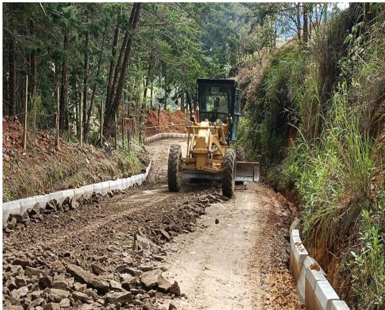
**Ilustración 21.** *Extensión de subbase granular en el tramo 02 La Enea. Fuente: informes de Consicor S.A.S.*
