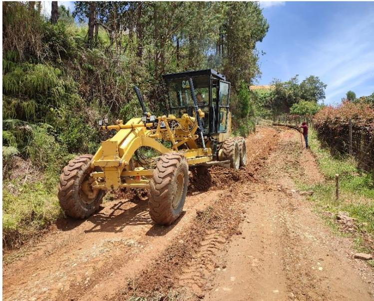
**Ilustración 15.** *Conformación de calzada existente con motoniveladora en el tramo 02 La Enea. Fuente: informes de Consicor S.A.S.*
