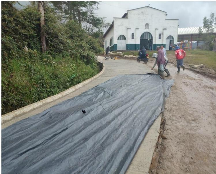
**Ilustración 46.** *Colocación de plástico de pavimento recién vaciado para evitar la lluvia.*
