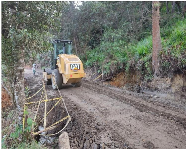
**Ilustración 12.** *Compactación de lleno en obra transversal. Fuente: informes de Consicor S.A.S.*
