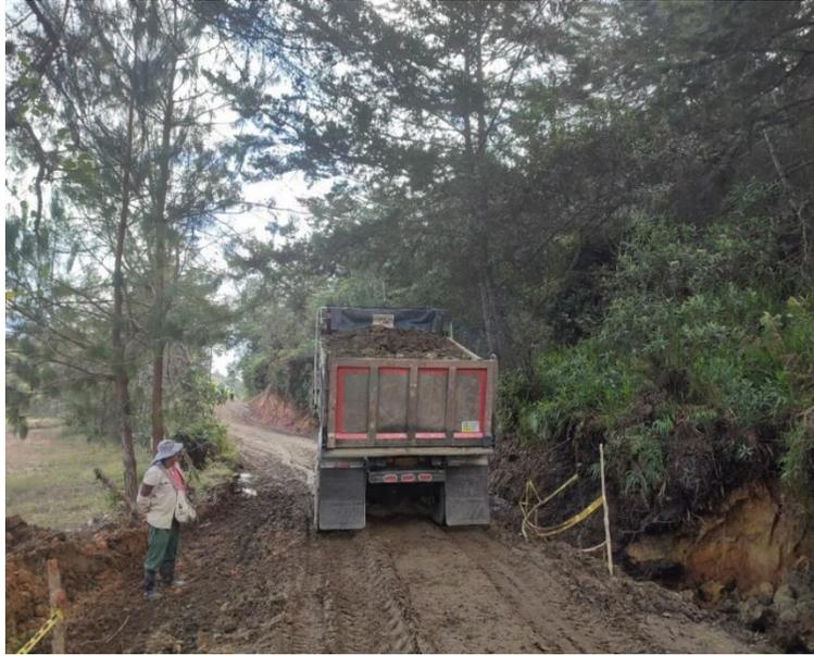
**Ilustración 17.** Transporte de subbase granular en el tramo 01 La Magdalena. Fuente: informes de Consicor S.A.S.
