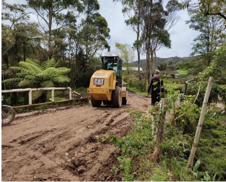
**Ilustración 14.** *Compactación de calzada existente con vibro compactador tramo 01 La Magdalena. Fuente: informes de Consicor S.A.S.*
