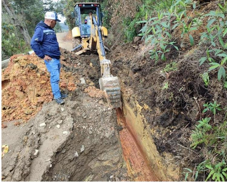
**Ilustración 39.** *Excavaciones para filtro en el tramo 01 La Magdalena. Fuente: informes de Consicor S.A.S.*
