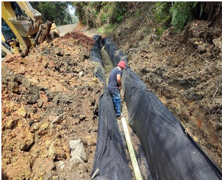
**Ilustración 40.** *Instalación de tubería para filtros en el tramo 02 La Magdalena. Fuente: informes de Consicor S.A.S.*
