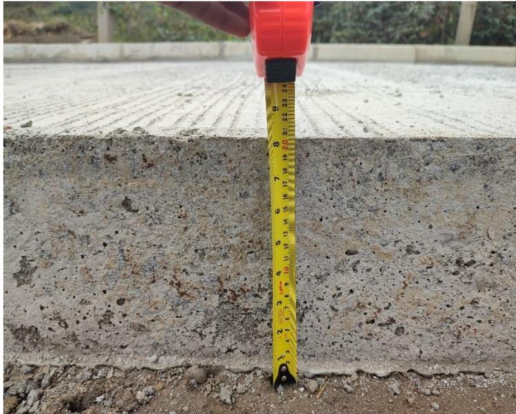
**Ilustración 43.** *Espesor de 0.20 m del carril pavimentado. Fuente: informes de Consicor S.A.S.*
