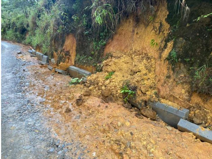
**Ilustración 47.** Derrumbe de bordillos a casusa de movimientos en masa en el tramo 02 La Enea. Fuente: informes de Consicor S.A.S.
