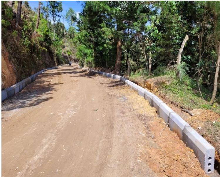
**Ilustración 26.** *Instalación de bordillos en el tramo 02 La Enea. Fuente: informes de Consicor S.A.S.*
