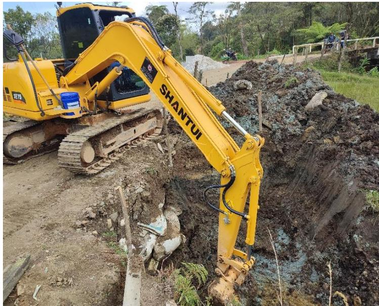
**Ilustración 27.** *Excavación de primera poceta de la obra transversal #1. Fuente: informes de Consicor S.A.S.*
