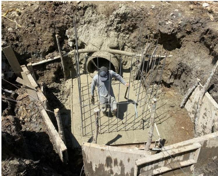
**Ilustración 32.** *Armado de segunda poceta de la obra transversal #1 en el tramo 01 La Magdalena. Fuente: informes de Consicor S.A.S.*
