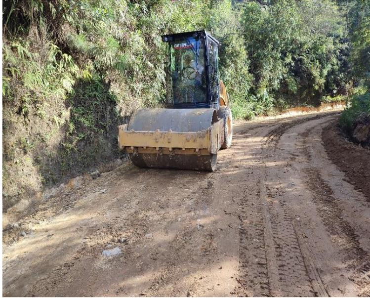
**Ilustración 16.** *Compactación de calzada existente con vibro compactador en el tramo 02 La Enea. Fuente: informes de Consicor S.A.S.*
