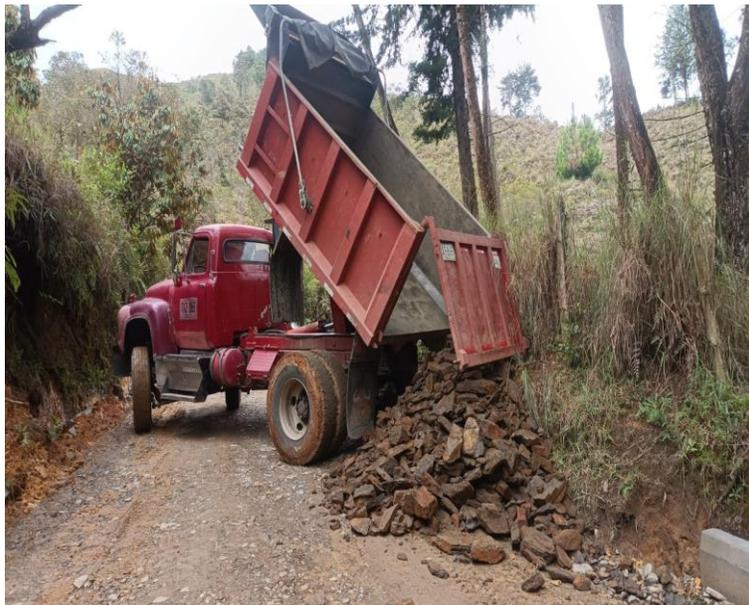
**Ilustración 18.** Transporte de subbase granular en el tramo 02 La Enea. Fuente: informes de Consicor S.A.S.
