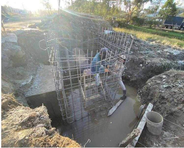
**Ilustración 31.** *Suministro, corte, figurado e instalación de acero de la primera poceta de obra transversal #1. Fuente: informes de Consicor S.A.S.*
