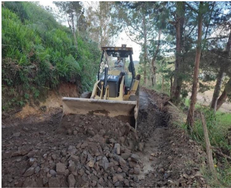
**Ilustración 19.** *Extensión de subbase granular en el tramo 01 La Magdalena. Fuente: informes de Consicor S.A.S.*
