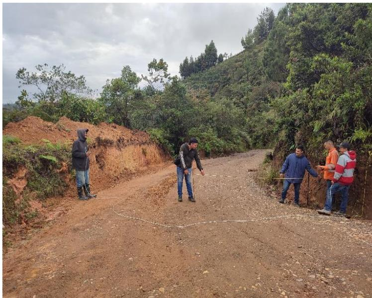
**Ilustración 8.** Localización y replanteo en el tramo 02 La Enea. Fuente: informes de Consicor S.A.S.
