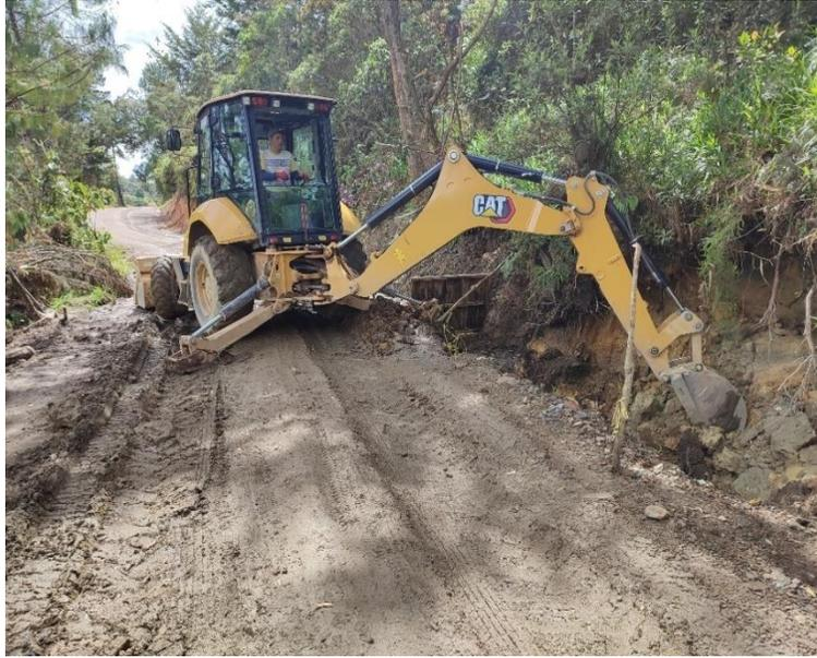
**Ilustración 30.** *Excavación de poceta de la obra transversal #2. Fuente: informes de Consicor S.A.S.*
