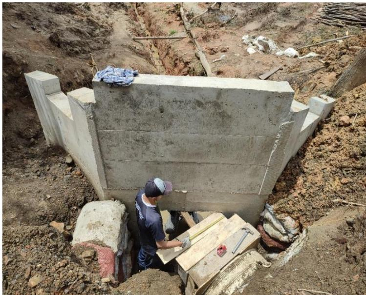
**Ilustración 37.** Descole de la obra transversal #2 en el tramo 01 La Magdalena. Fuente: informes de Consicor S.A.S.
