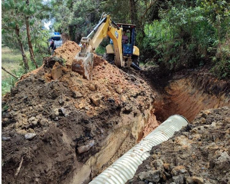
**Ilustración 10.** *Implantación de tubo para obra transversal. Fuente: informes de Consicor S.A.S.*
