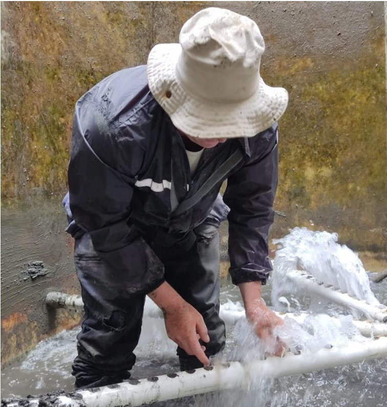
Figura 16. Clarificador después de mantenimiento.
