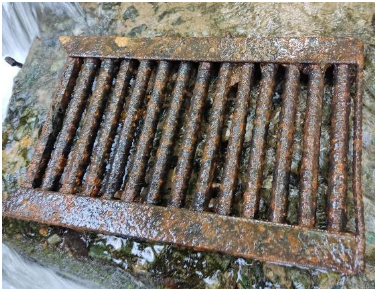
Figura 3. Rejilla superficial creada por los operarios.
