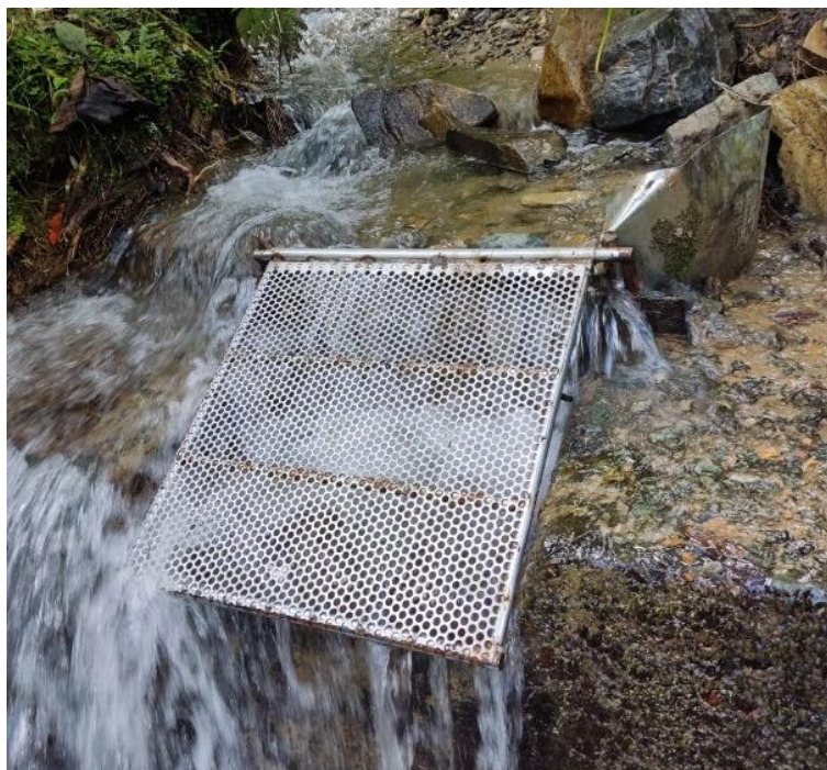
Figura 3. Rejilla superficial creada por los operarios.
