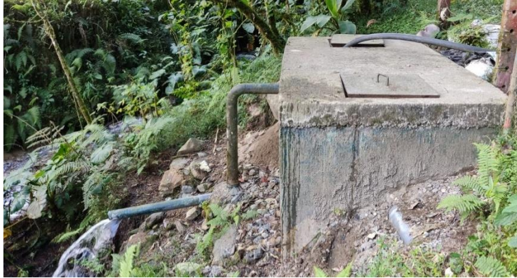
Figura 6. Desarenador vista de perfil.
