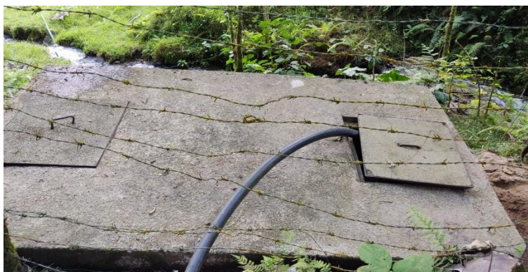
Figura 5. Desarenador vista superior.
