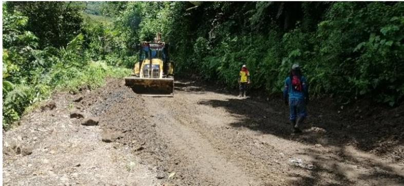
Posteriormente se procede a realizar la compactación del material de subbase hasta obtener una densidad seca mayor al 95% del ensayo Proctor Modificado. La humedad del material se controla de manera que permanezca en el rango requerido para obtener la densidad especificada.
