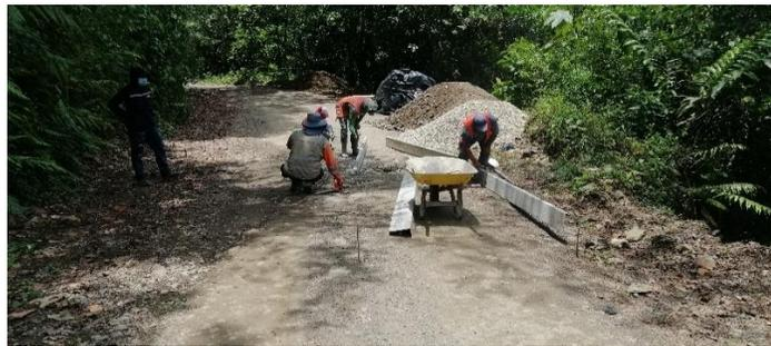
**Figura 5.** *Instalación de formaletas*
