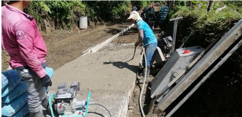
**Figura 11.** *Alisado y acabado del concreto.*
