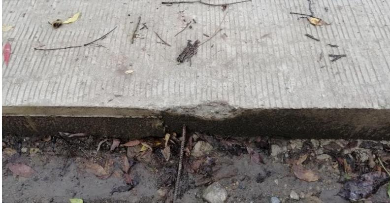
**Figura 18.** *Despostillamientos de losa y aplastamiento de las barras de amarre*
