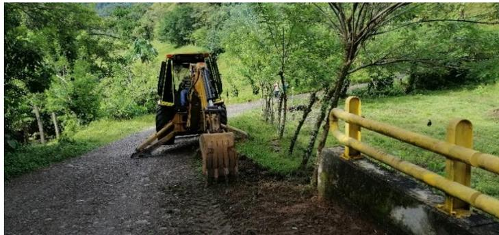
Luego de realizar las excavaciones y cortes en la subrasante, se procede a realizar el regado del material de subbase y su conformación en la vía a través de explanaciones hasta alcanzar el espesor de diseño que según las especificaciones es de 150 mm.
