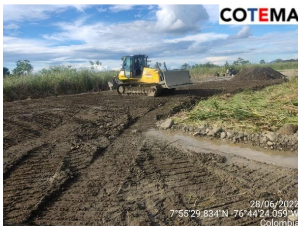
Figura 10. Conformación de vías de acceso
