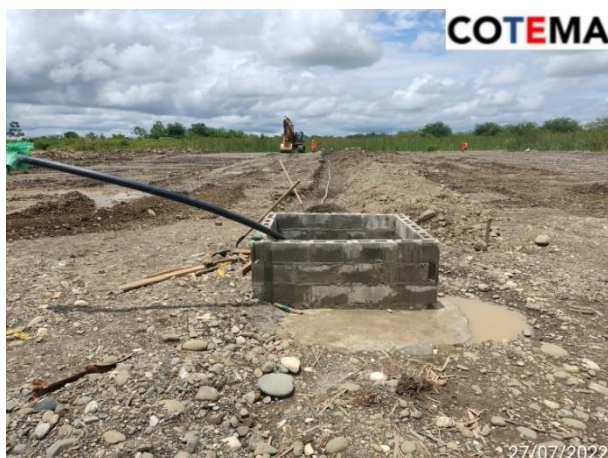
Figura 12. Excavaciones de ductos para el perfilómetro
