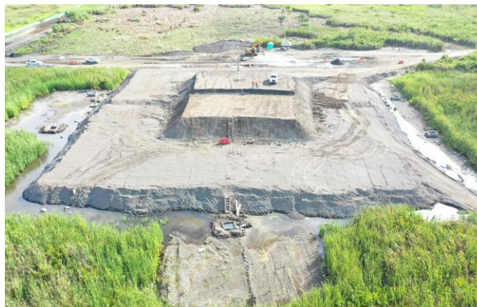
Figura 15. Terraplén de carga terminado
