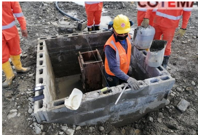
Figura 11. Construcción de cajas de inspección
