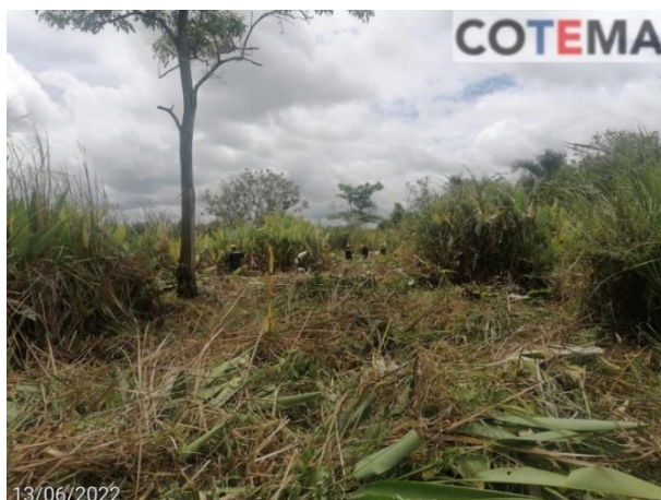
Figura 9. Remoción de vegetación en zona de la prueba de carga
