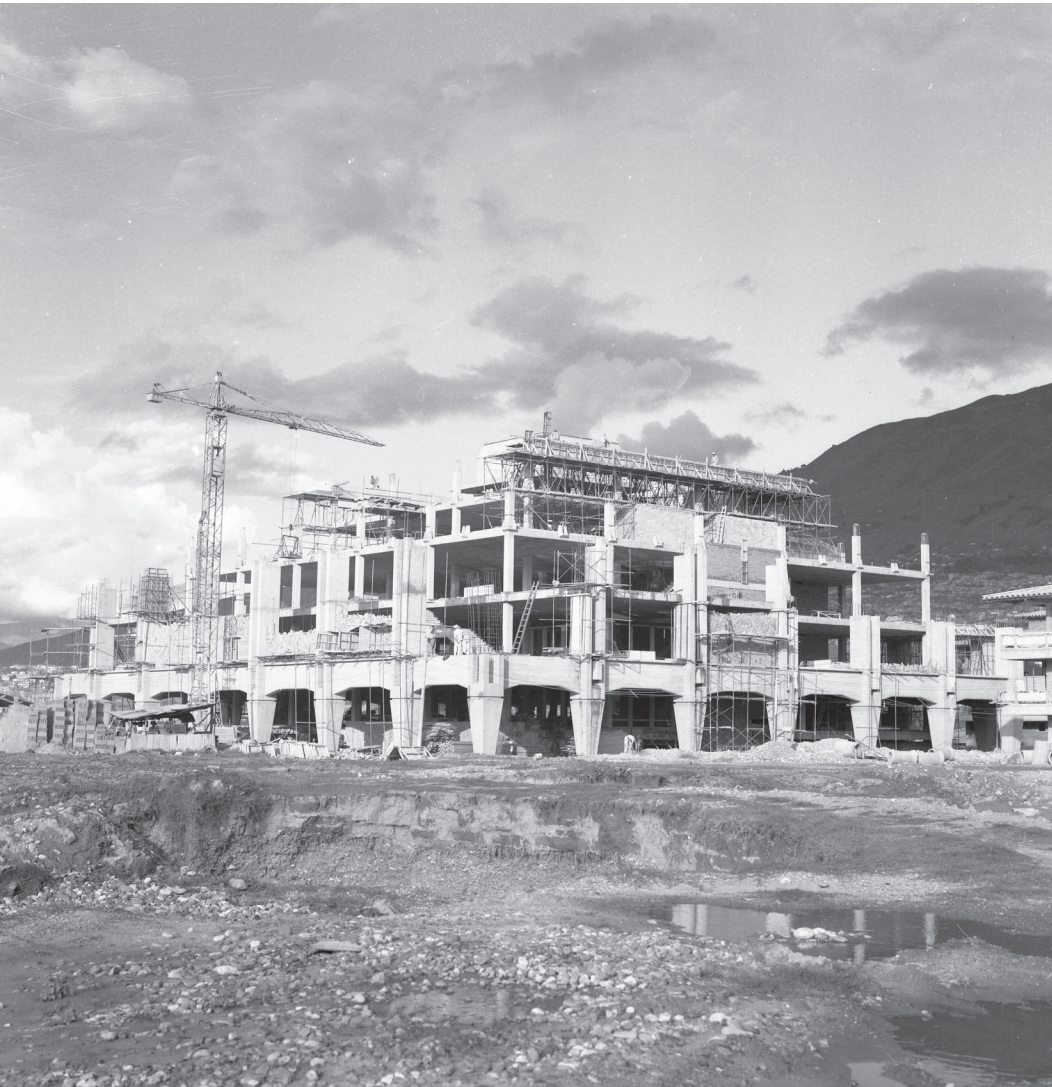
Fotografía Diego García Digar. Construcción Biblioteca Central. 1967
