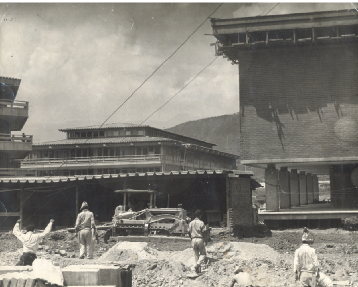
Fotografía Diego García Digar. Construcción Ciudadela Universitaria 1967
