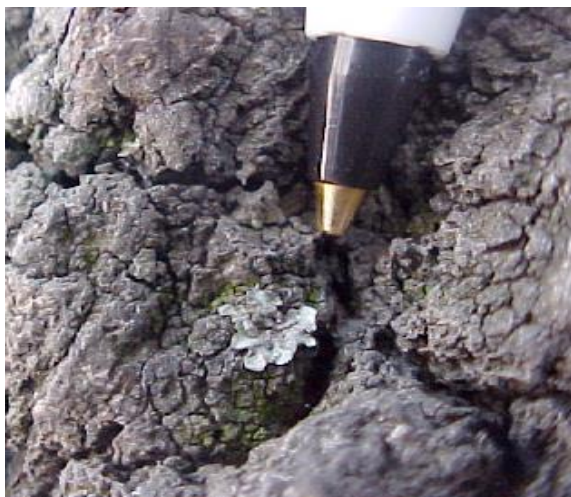
Fotografía: M. Gómez Peralta
