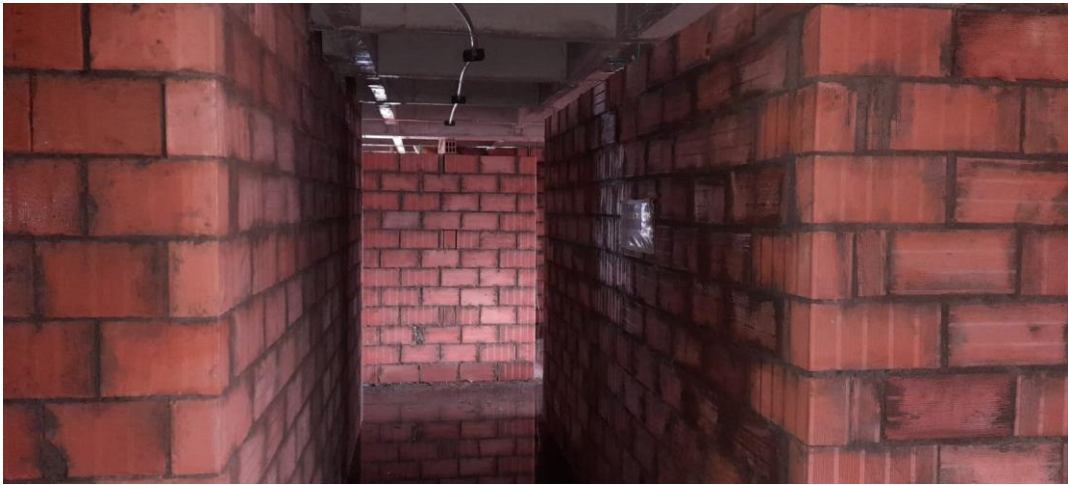
Fig. 7. Zonas mal iluminadas Fuente: propia
