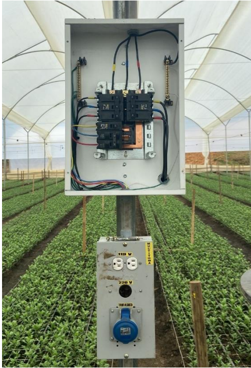
Fig. 10 Revisión de ejecución
