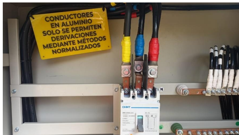
Fig. 11 Revisión de ejecución
