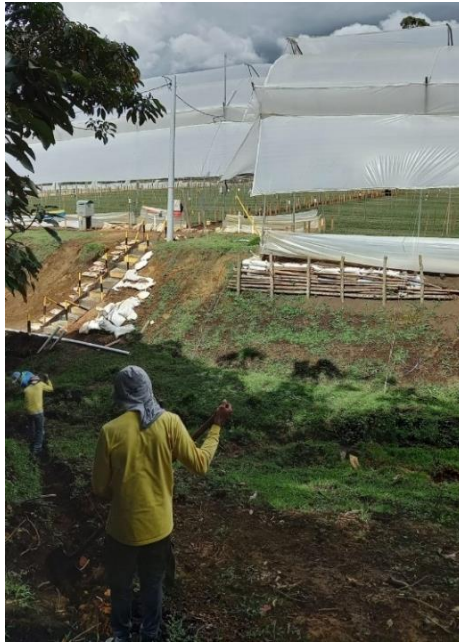
Fig. 1 Vías de acceso para instalación de postes
