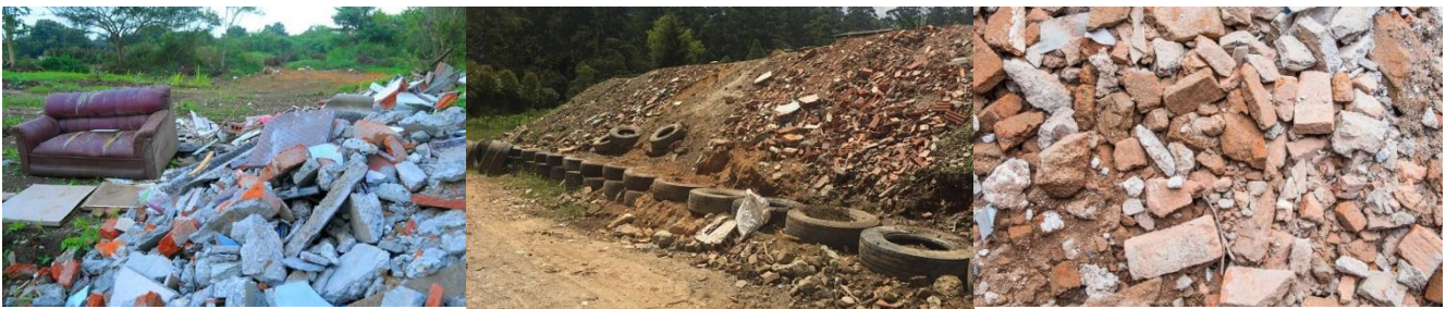
Fig. 4. Disposición inicial de los residuos de construcción y demolición.
