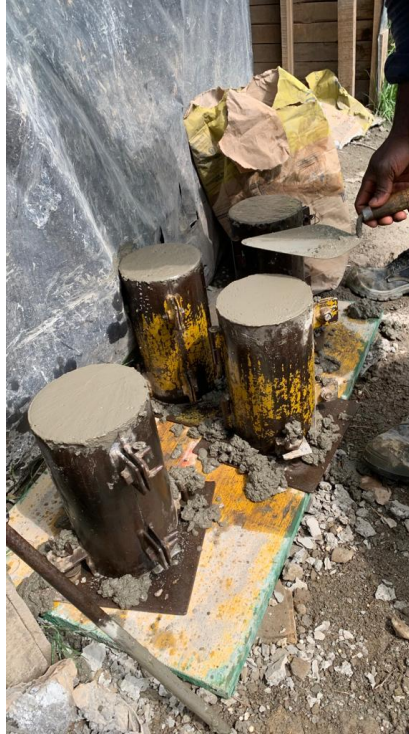
Figura 12 Cilindros llenos de concreto hecho en obra
