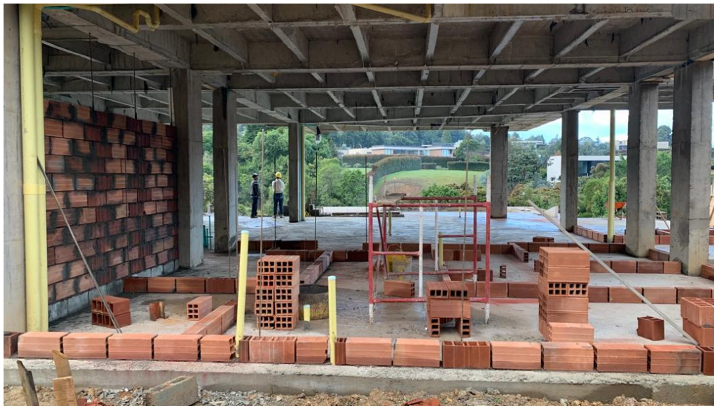
Figura 9 Construcción de muros de mampostería
