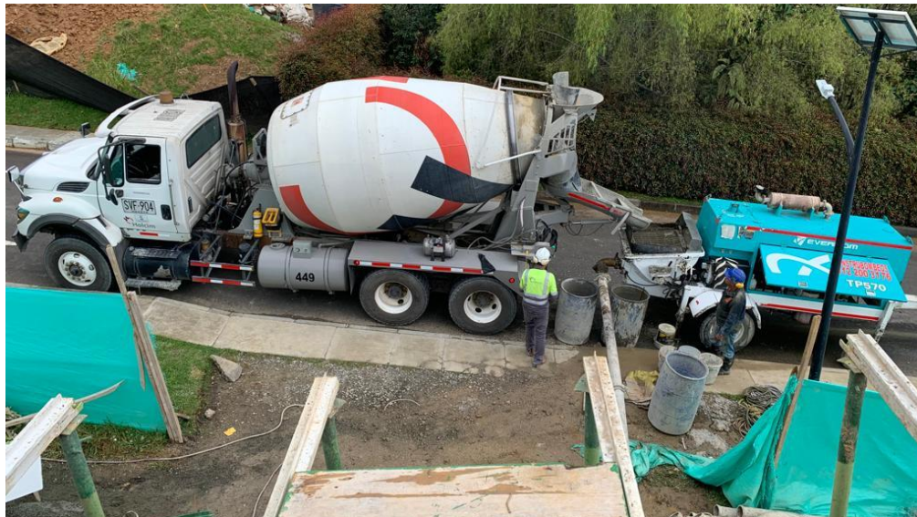
Figura 18 Mixer de Holcim descargando concreto premezclado para el bombeo.
