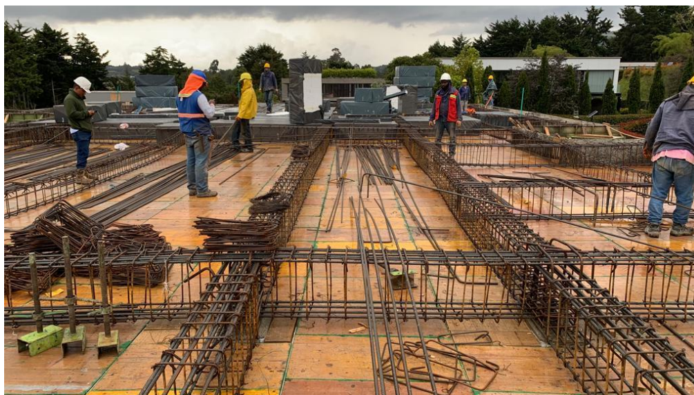
Figura 5 Instalación de acero en la losa
