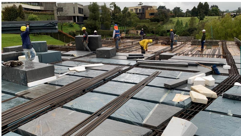
Figura 6 Instalación de porón (icopor) en la losa
