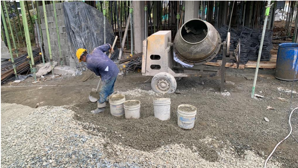
Figura 10 Concreto hecho en obra con mezcladora
