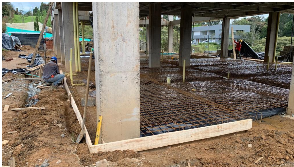
Figura 8 Instalación de mallas electrosoldadas en el contrapiso
