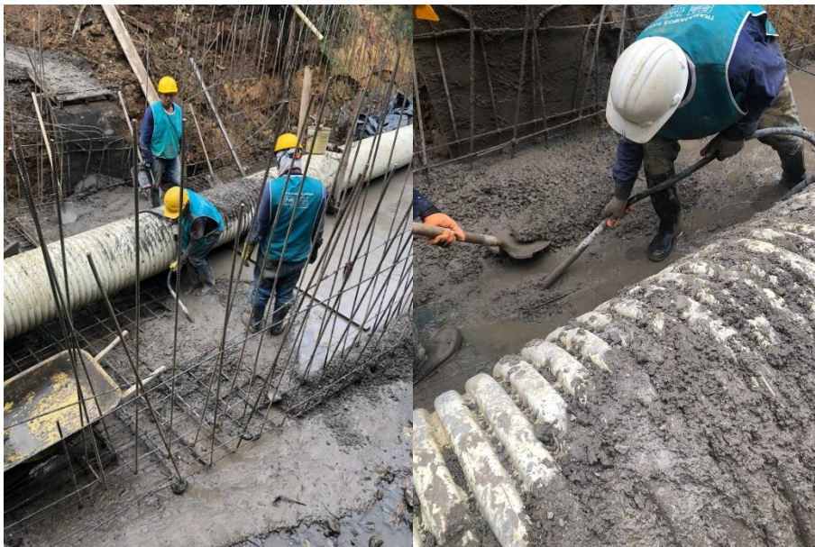
Figura 12 Vibrado del concreto de la losa
