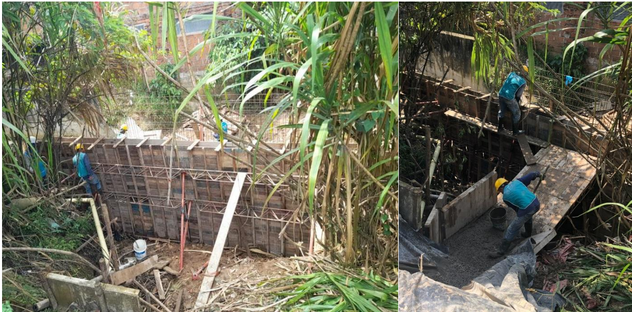
Figura 13 Encofrado de muros de concreto y vaciado
