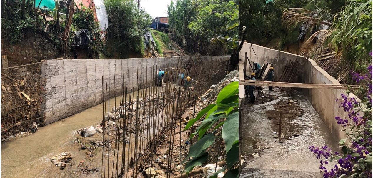
Figura 14 Muro construido a la fecha
