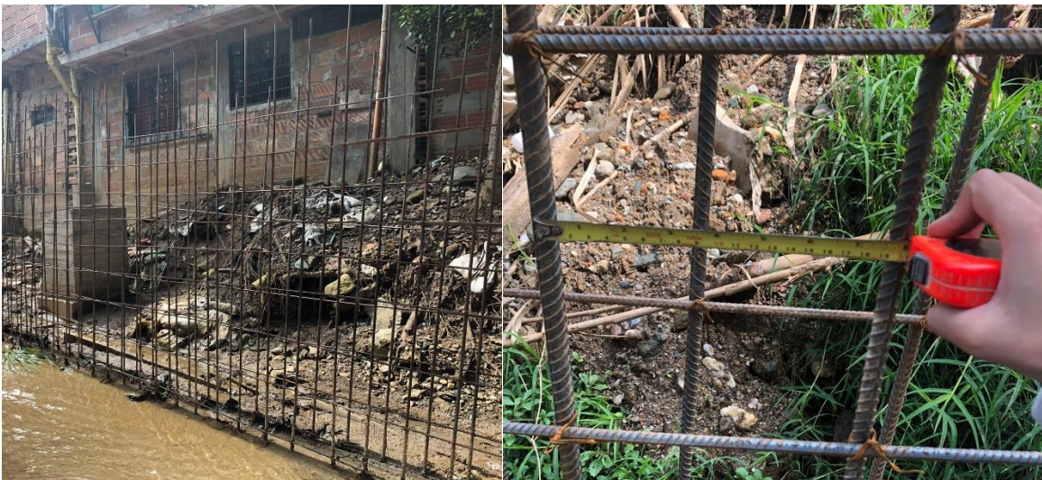
Figura 10 Acero muros
