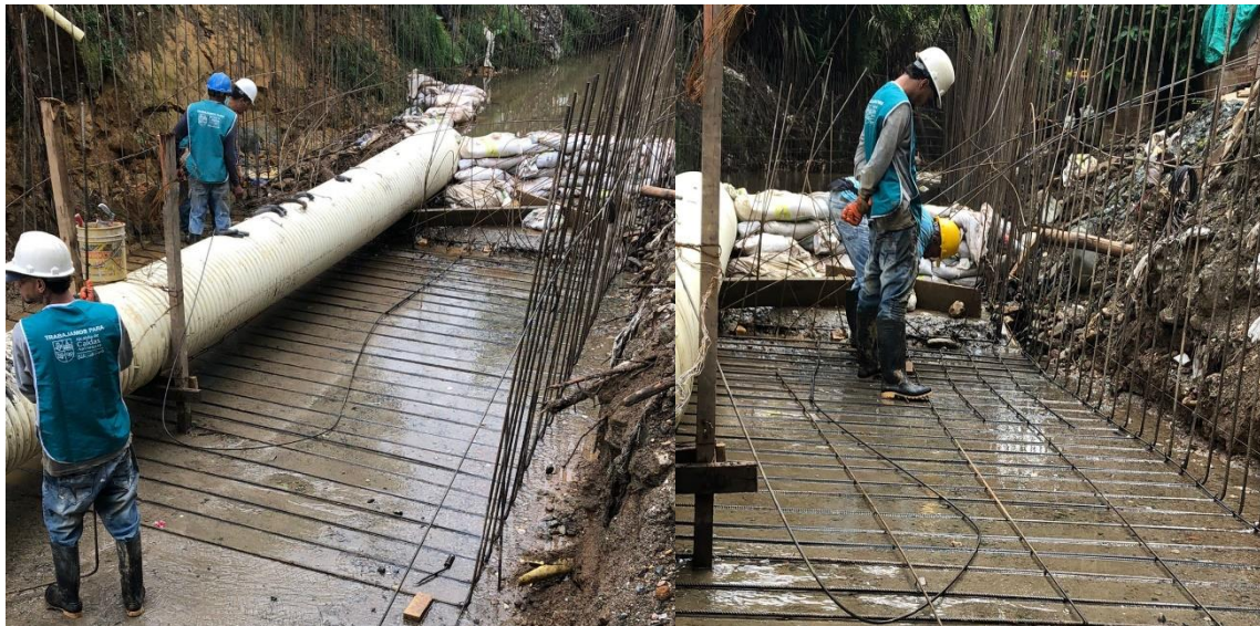
Figura 8 Acero figurado
