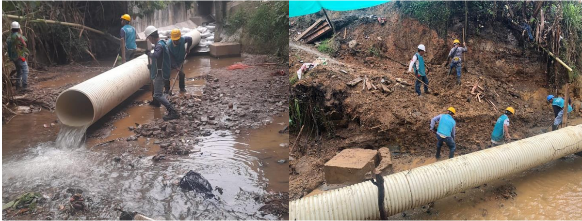
Figura 7 Excavación manual de material heterogéneo
