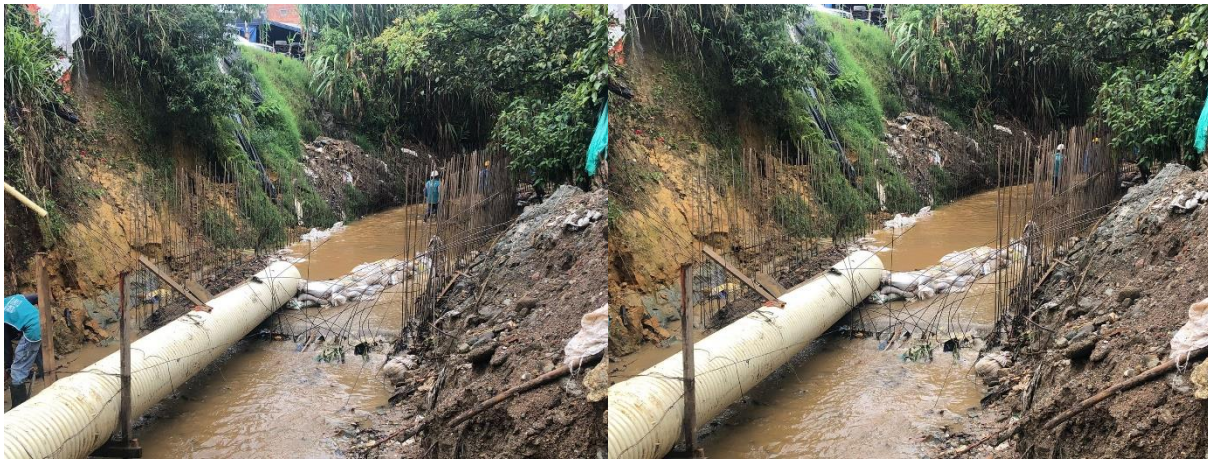
Figura 6 Desvío de aguas
