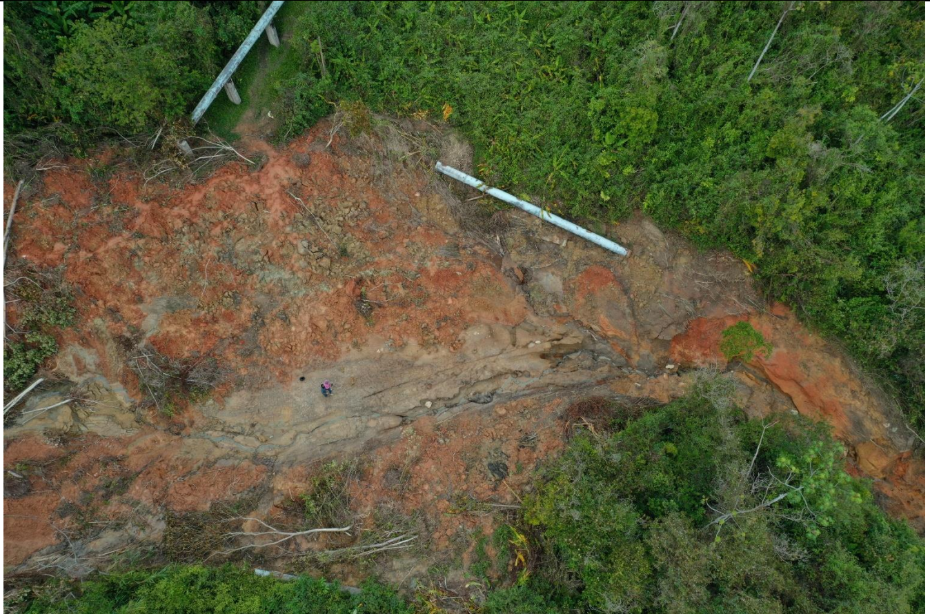
Fotografía 2. Movimiento en masa barrio Villa Lía.
