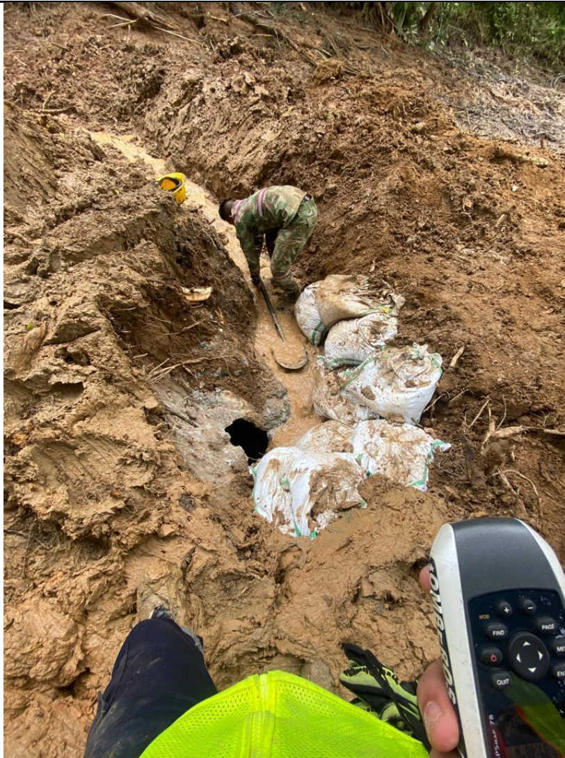
Fotografía 9. Rehabilitación de obra hidráulica para control de escorrentía
